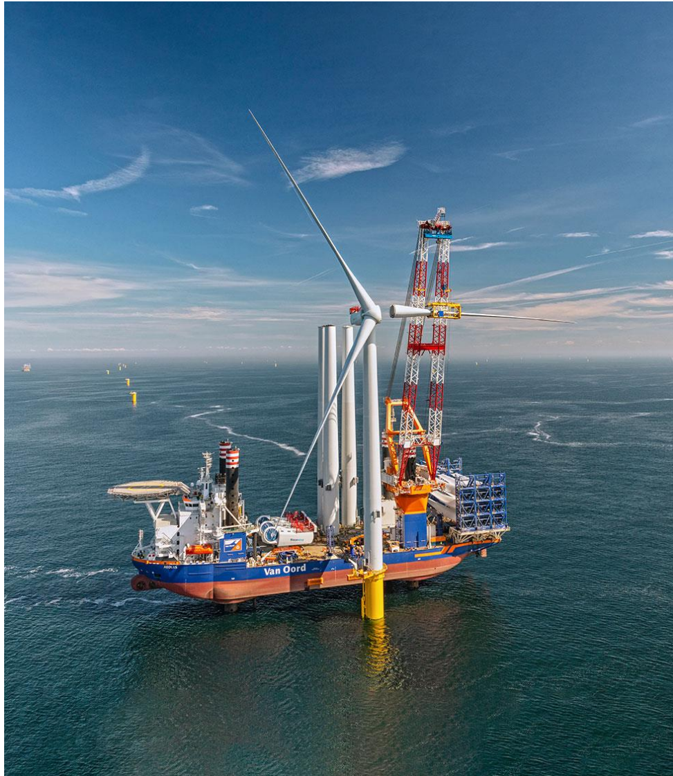
ΣΧΗΜΑ 19. Κατασκευή ανεμογεννήτριας σε υπεράκτιο αιολικό πάρκο (ΠΗΓΗ: DNV)
