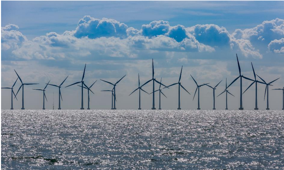
ΣΧΗΜΑ 15. Το μεγαλύτερο παράκτιο αιολικό πάρκο στον κόσμο Dogger Bank στην Δανία (ΠΗΓΗ: AZOCLEANTECH)
