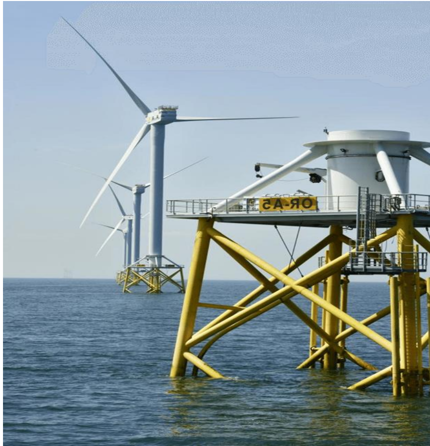
ΣΧΗΜΑ 22. Jacket foundation 1 (ΠΗΓΗ: OFFSHOREWIND)
