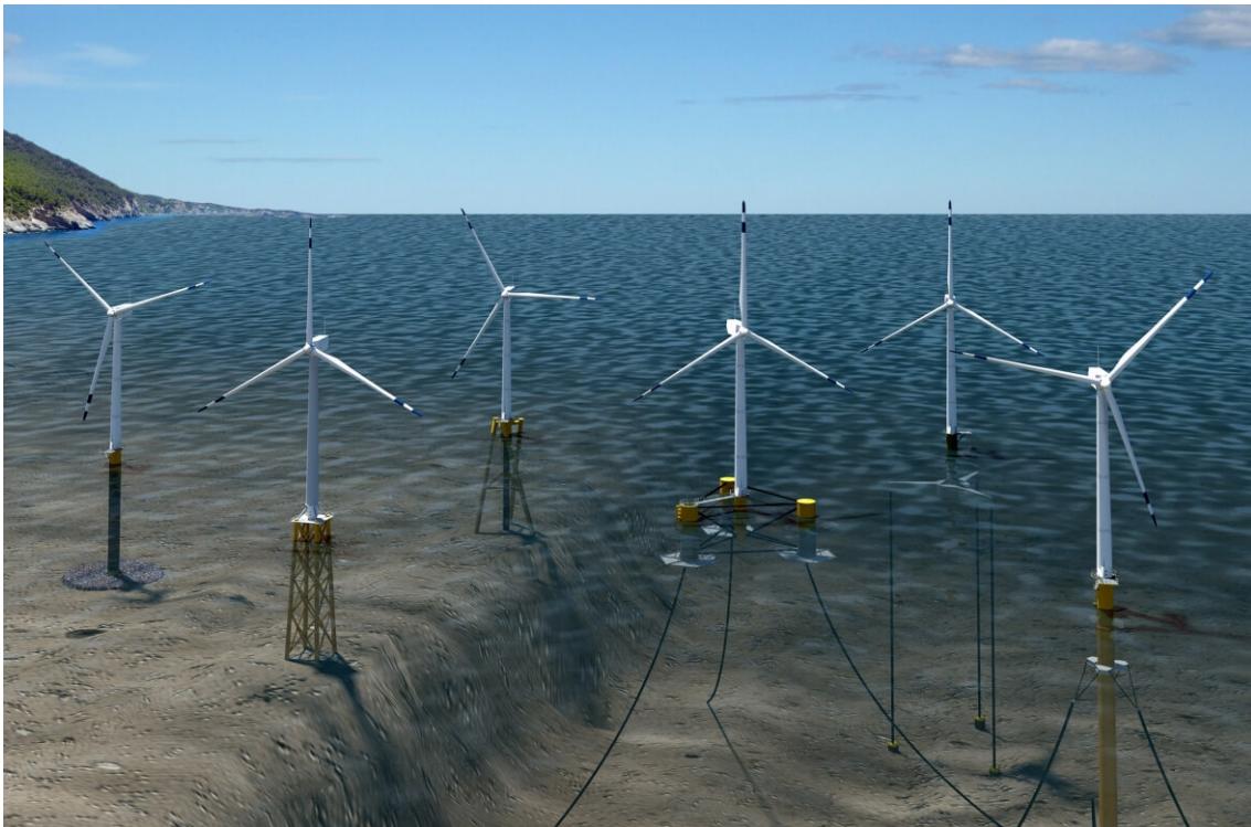
Σχήμα 5: Τύποι υπεράκτιων Α/Γ. Απεικόνιση από NREL.
