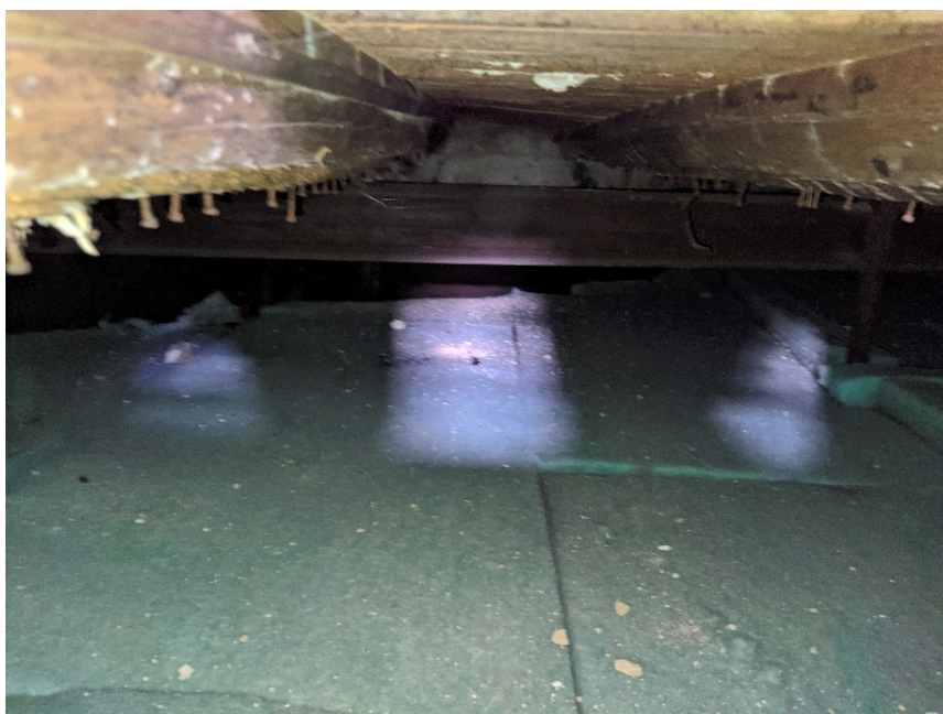
Εικόνα 3.2.1 Ξυλοδοκοί στηριζόμενες σε μεταλλικές δοκούς
