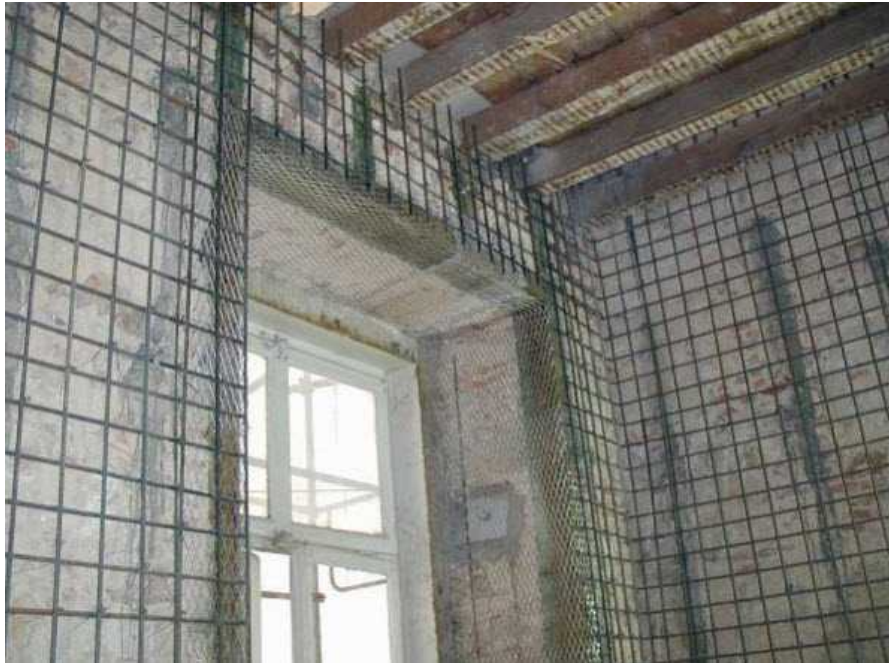
Εικόνα 3.7.3 Προετοιμασία για εφαρμογή μανδύα οπλισμένου σκυροδέματος σε κτίριο από φέρουσα τοιχοποιία.
