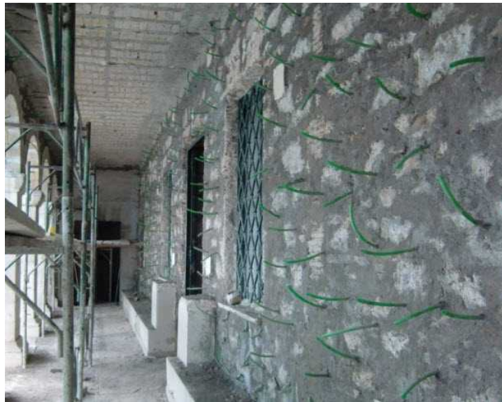
Εικόνα 3.7.2 Εφαρμογή σωληνίσκων για ομογενοποίηση τοιχοποιίας.
