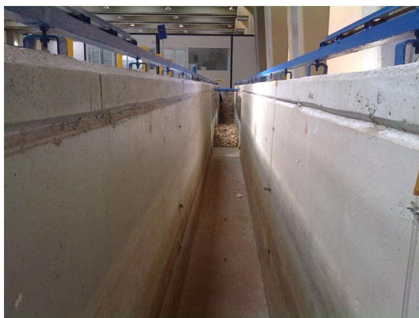
Σχήμα 3.1.1.3 – Άποψη του εσωτερικού της διώρυγας βαρύτητας του εργαστηρίου λιμενικών έργων.
