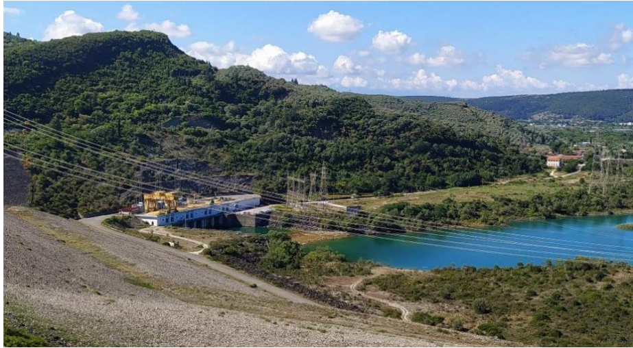
Εικόνα 3.6: Ο σταθμός παραγωγής ενέργειας (Ντεμίρογλου, 2020)
