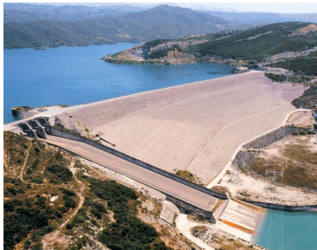
Εικόνα 3.4: Φράγμα Πουρναρίου I (Roilos, 2018)
