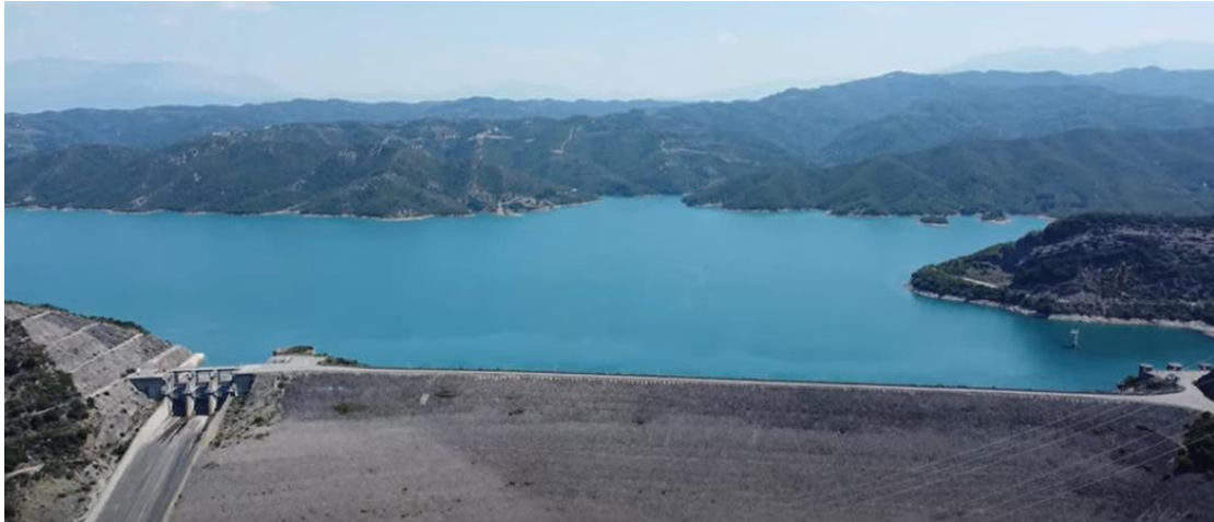
Εικόνα 3.5: Ταμιευτήρας φράγματος Πουρναρίου Ι
