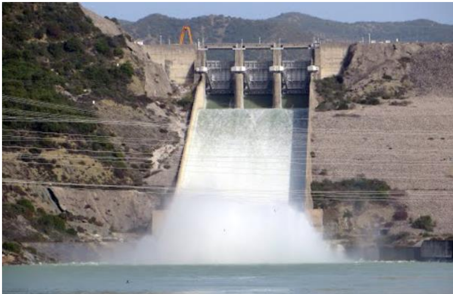
Εικόνα 3.10: Έργο υπερχειλίσης Πουρναρίου Ι
