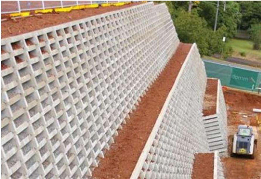
4. Τοίχος βαρύτητας από προκατασκευασμένα κιβώτια (Πηγή: https://theconstructor.org/ )
