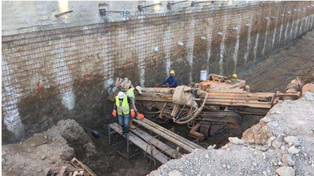
8. Τοίχος αντιστηρίξεως τύπου «Βερολίνου» (Πηγή: https://www.geostatik.gr )
