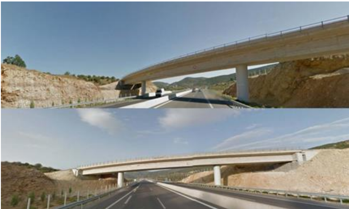
Εικόνα 18: Η Γέφυρα στον Αυτοκινητόδρομο Τρίπολης - Καλαμάτας.
