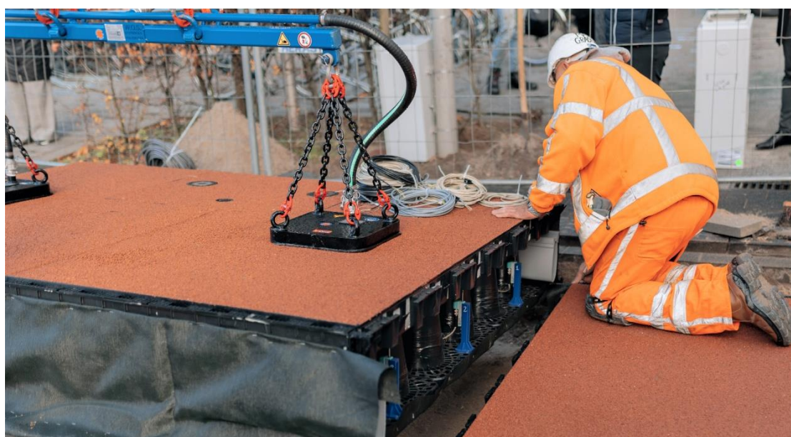
Εικόνα 103: Εγκατάσταση υποδομής ποδηλατοδρόμων σε κομμάτια
