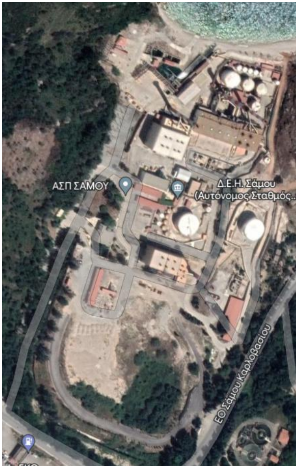
Εικόνα 4 ΑΠΟΨΗ ΕΓΚΑΤΑΣΤΑΣΕΩΝ ΑΣΠ ΣΑΜΟΥ
