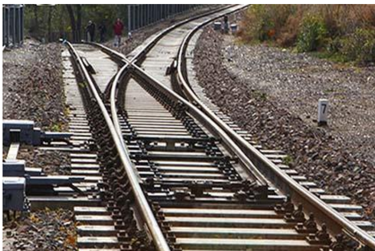
Σχ. 6 Σιδηροδρομικό σύστημα εκτροπής. (Πηγή: https://www.railroadpart.com/news/railway-turnout-and-guard-rail-function-overview.html )
