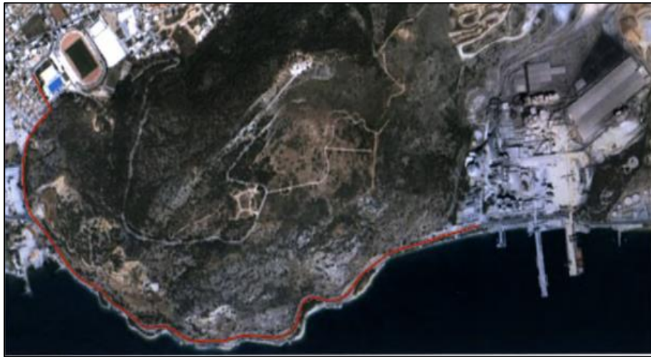
Εικόνα 8 Τηλεθέρμανση (πηγή: Μελέτη συστήματος τηλεθέρμανσης του ΕΑΚ Βόλου )
