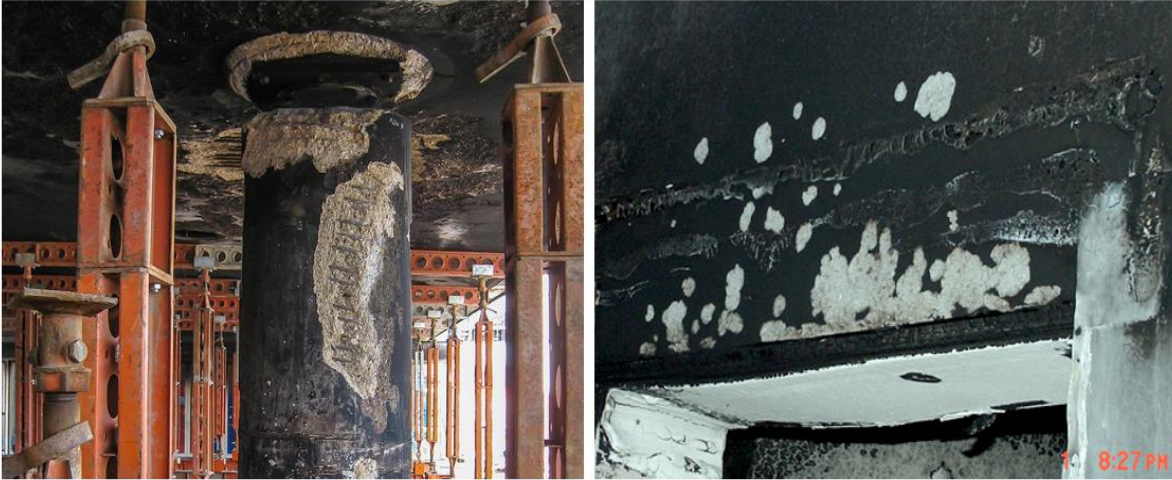
Εικόνα 15: Διαφορά μεταξύ σημαντικής και μη αποκόλλησης
