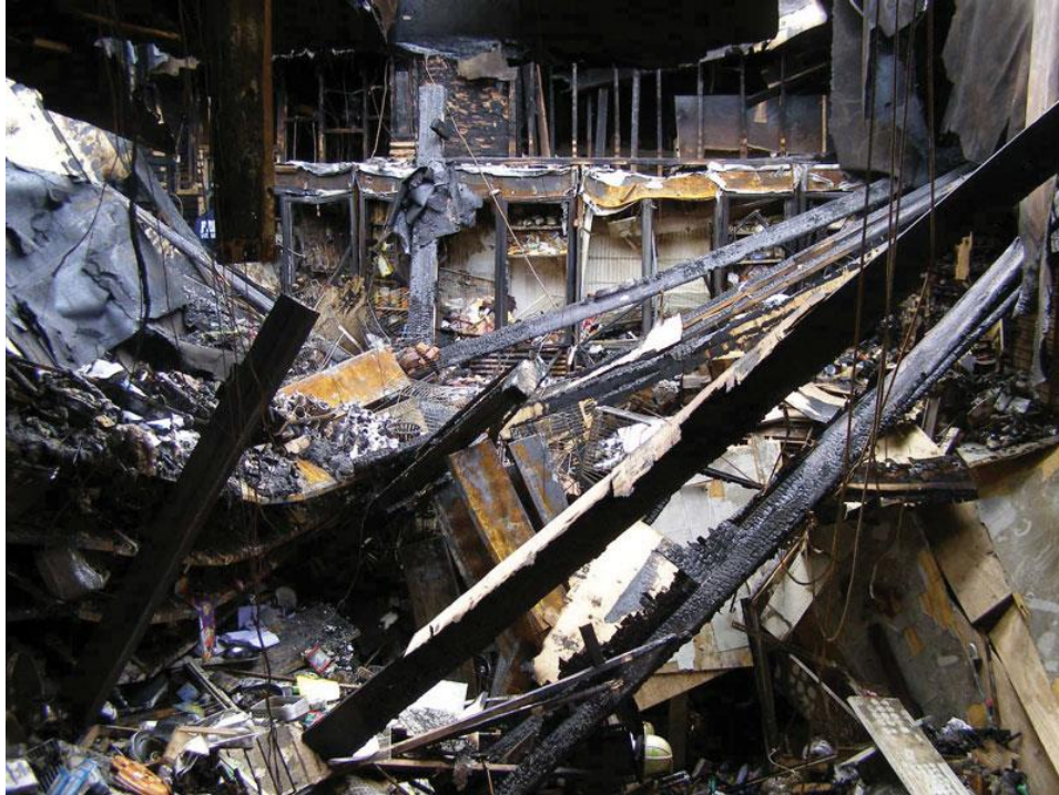
Εικόνα 36: Κατάρρευση ξύλινης κατασκευής με ακέραιες δοκούς
