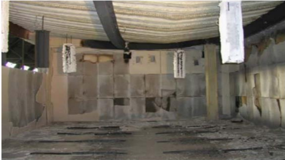
Εικόνα 29: Υπερβολικό βέλος κάμψης δοκού
