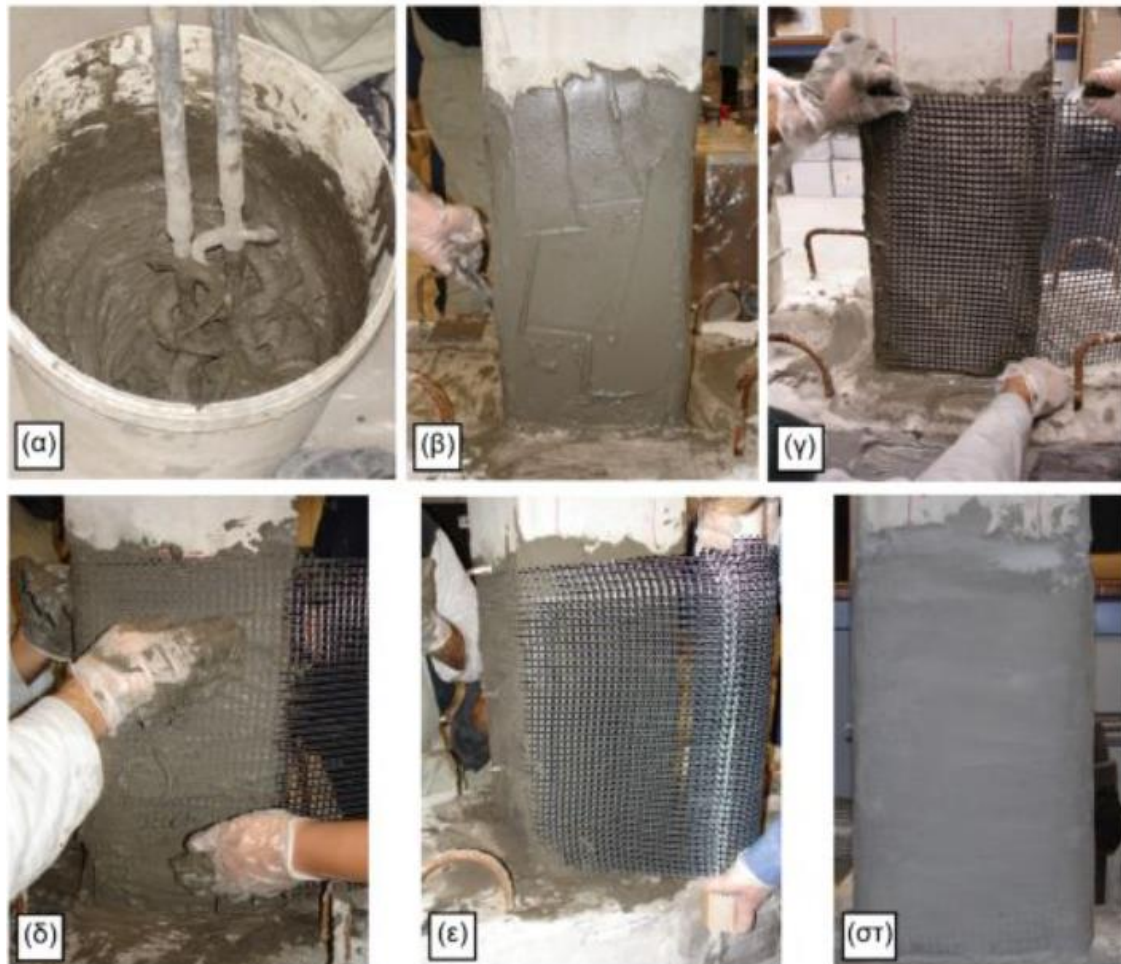
Σχήμα 2.6: Τυπική διαδικασία ενίσχυσης υποστυλώματος με TRM
