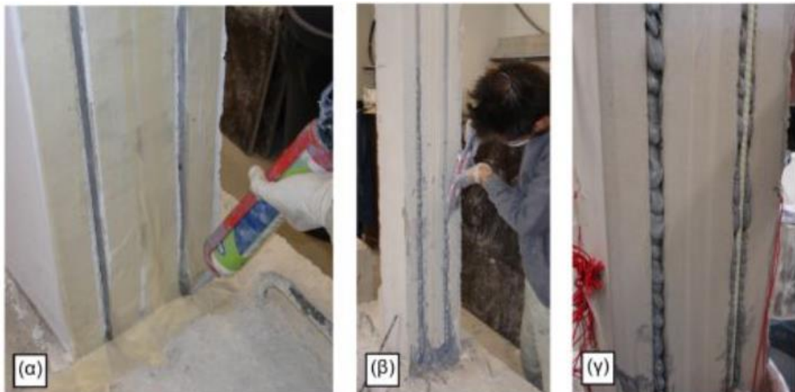
Σχήμα 2.4: Τυπική διαδικασία ενίσχυσης υποστυλώματος με NSM
