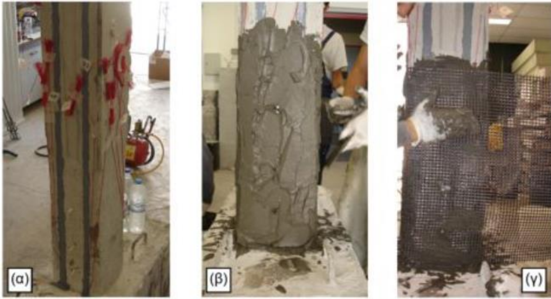
Σχήμα 2.8: Συνδυαστική εφαρμογή NSM και TRM σε υποστύλωμα
