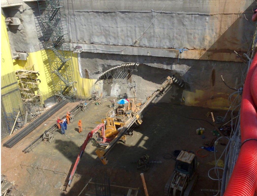
Τοποθέτηση δοκών προπορείας- Forepoling (Πηγή: 09/06/2008 ,Αττικό Μετρό Α.Ε.)
