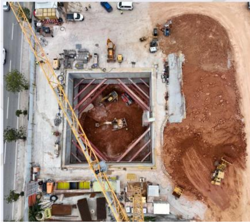
Εικόνα 2-7: Εξοκαφή σε εξέλιξη στο φρέαρ ΓΝΑ (Πηγή: Ενημερωτικό τεύχος της γραμμής 4 A Μάρτιος-Απρίλιος 2023, Αττικό Μετρό Α.Ε.)
