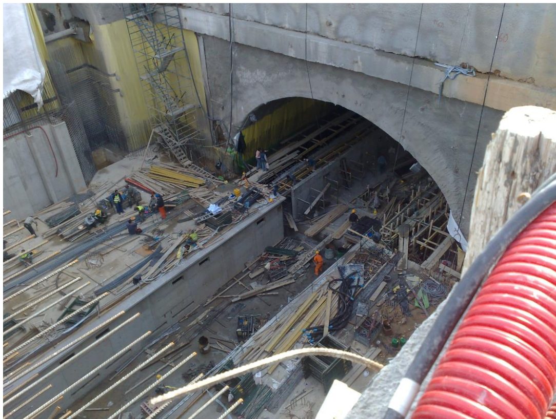
Εικόνα 2-5: Κατασκευή αποβάθρας ( Πηγή: 27/11/2008, Αττικό Μετρό Α.Ε.)
