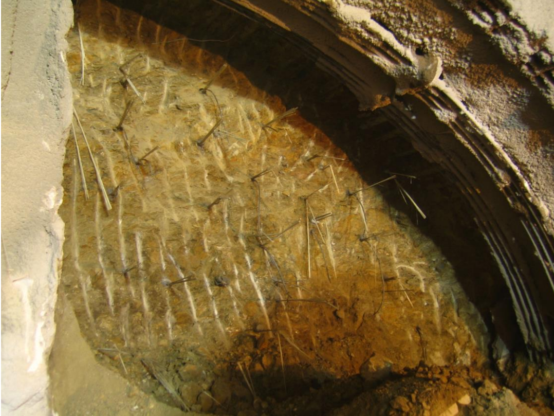
Αγκύρια μετώπου fiberglass (Πηγή: 18/08/2008 ,Αττικό Μετρό Α.Ε.)
