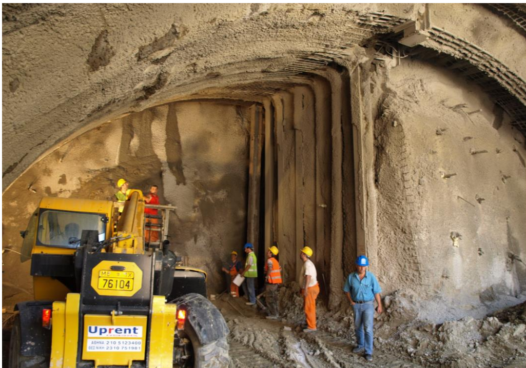
Εκσκαφή φάσης Α1 (Πηγή: 23/07/2008 ,Αττικό Μετρό Α.Ε.)
