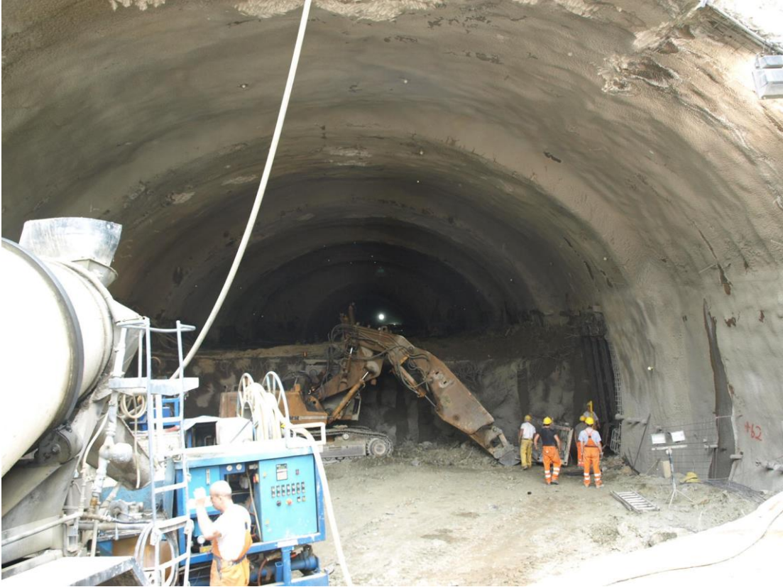
Ολοκλήρωση διάνοιξης Φάσης Α (Πηγή: 19/09/2008 ,Αττικό Μετρό Α.Ε.)
