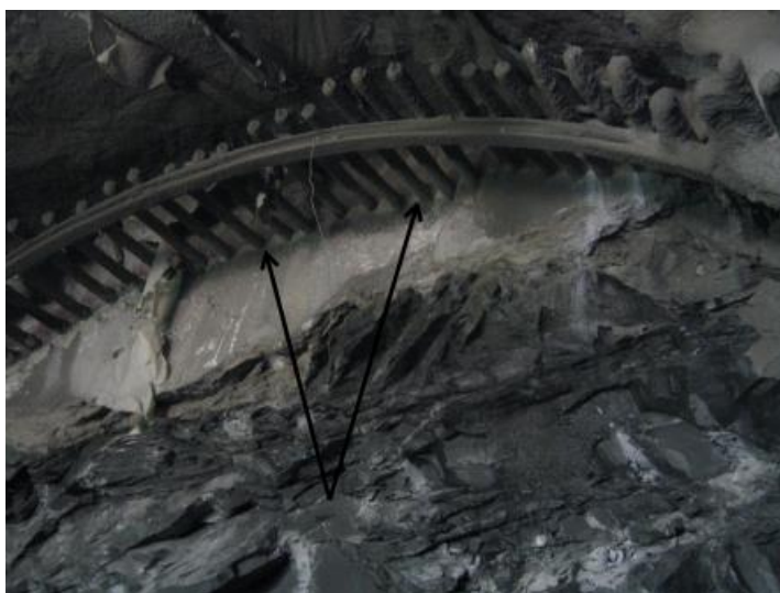
Εικόνα 3-15: Ελαφρά βλήτρα προπορείας spiles ( Πηγή: Β.Μαρίνος, Βραχομηχανική-Σήραγγες)
