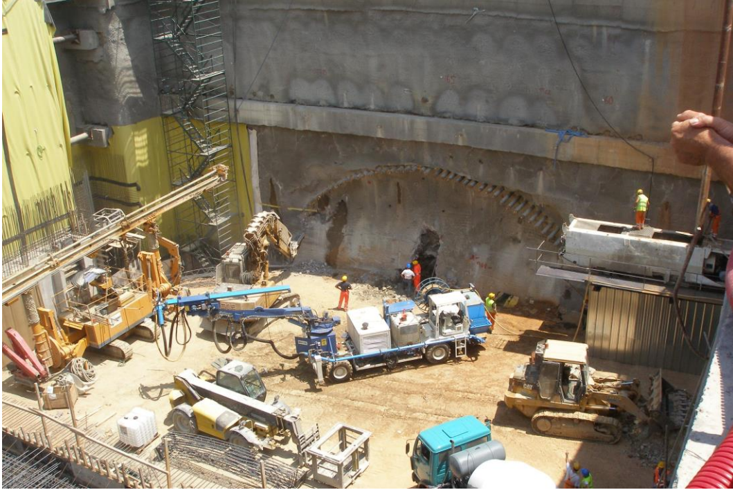
Εικόνα 2-3: Έναρξη εκσκαφής ( Πηγή: 30/06/2008, Αττικό Μετρό Α.Ε.)
