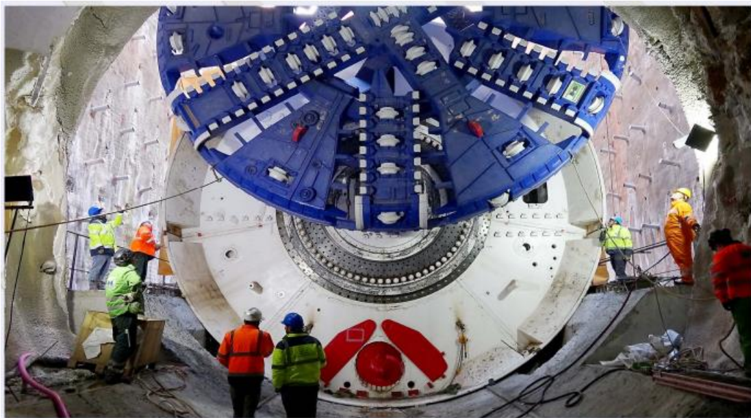
Εικόνα 2-8: Καταβίβαση κεφαλής ΤΒΜ (Πηγή: Ενημερωτικό τεύχος της γραμμής 4 A Μάρτιος-Απρίλιος 2023, Αττικό Μετρό Α.Ε.)
