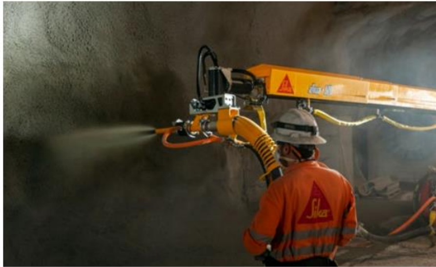
Εικόνα 3-11: Εκτοξευόμενο σκυρόδεμα/Gunite (Πηγή: https://can.sika.com/content/dam/dms/corporate/n/glo-sprayed-concrete-handbook-2021.pdf )
