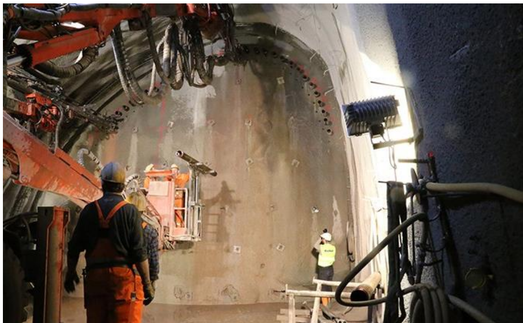
Εικόνα 3-16 : Ομπρέλα βαριών δοκών προπορείας/(Forepoling umbrella (Πηγή: https://www.robitgroup.com/?applications=forepoling )
