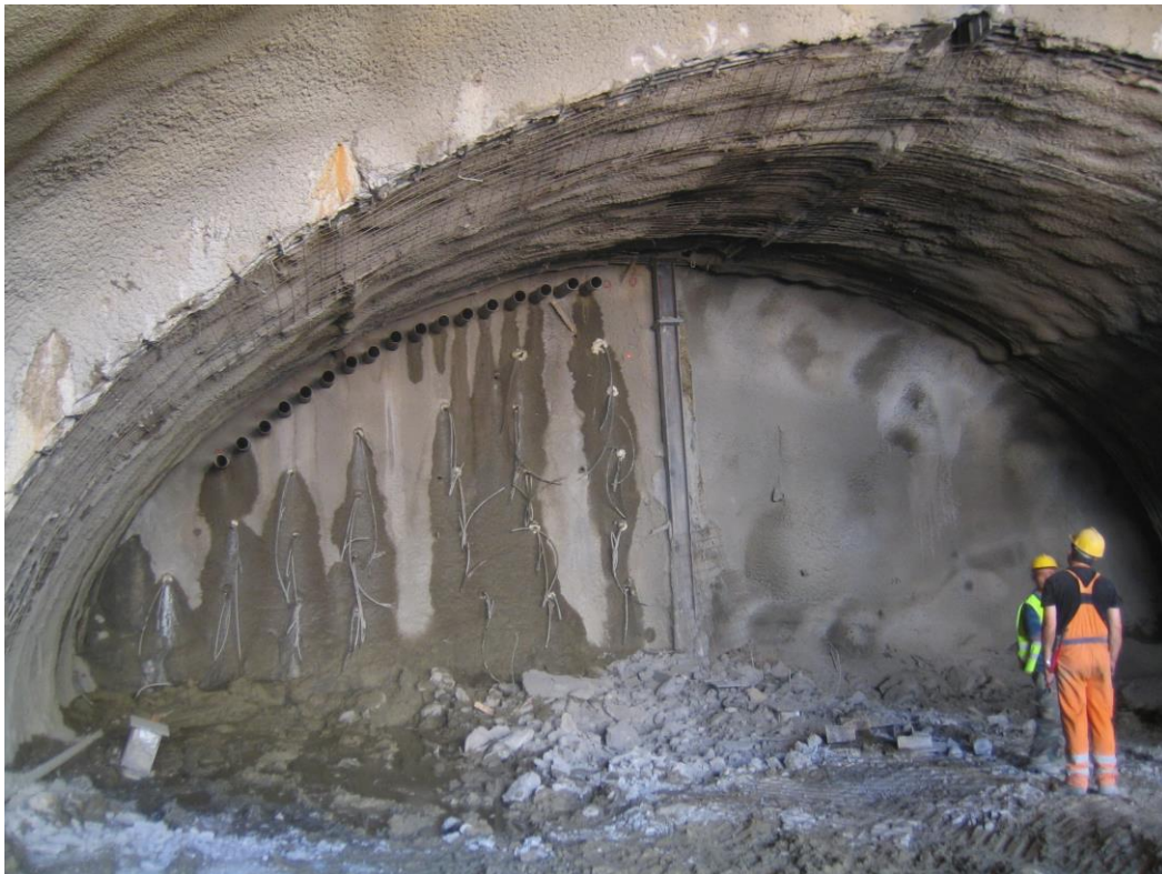
Καθαίρεση ενδιάμεσου τοιχώματος A1 και A2 (Πηγή: 21/08/2008 ,Αττικό Μετρό Α.Ε.)
