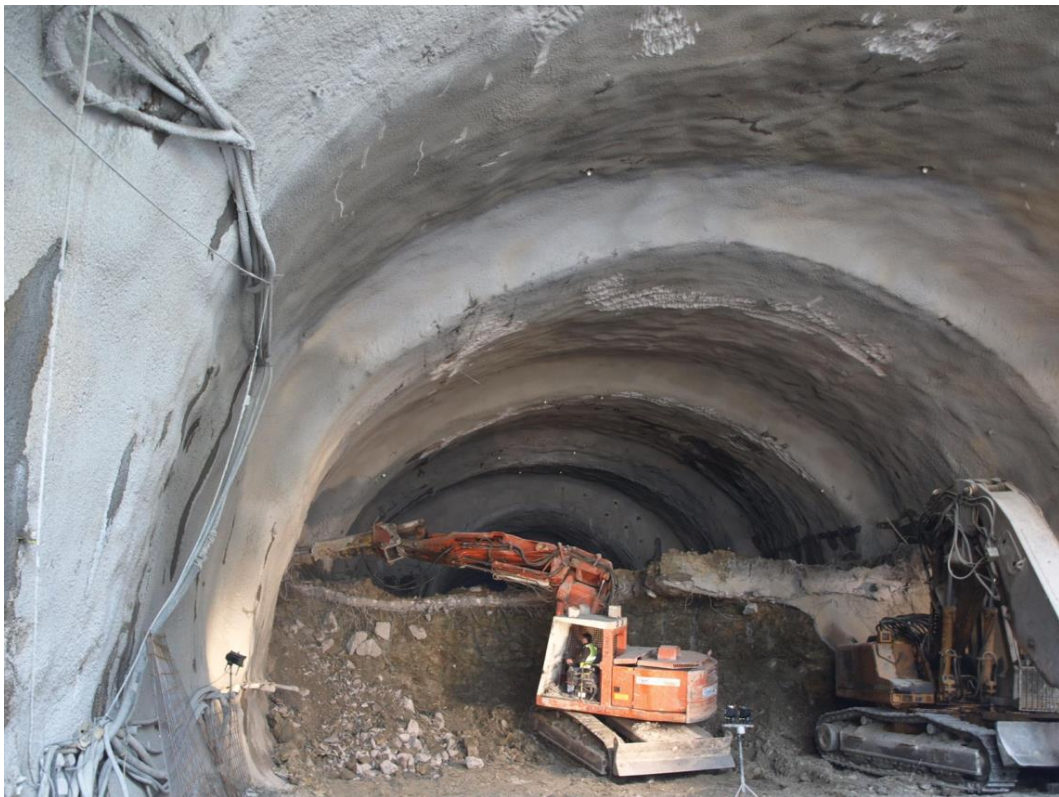
Εικόνα 2-4: Εκσκαφή φάσης Β -Bench ( Πηγή: 22/09/2008, Αττικό Μετρό Α.Ε.)
