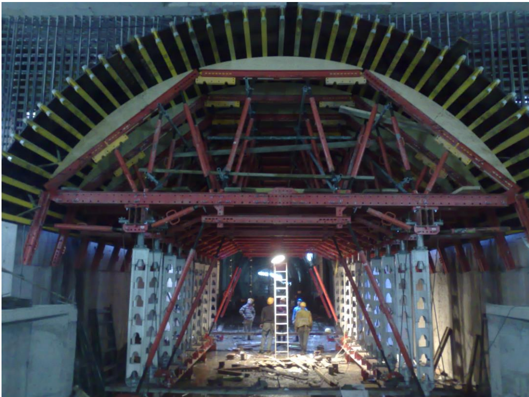
Τελική Επένδυση σήραγγας (Πηγή: 18/12/2008 ,Αττικό Μετρό Α.Ε.)
