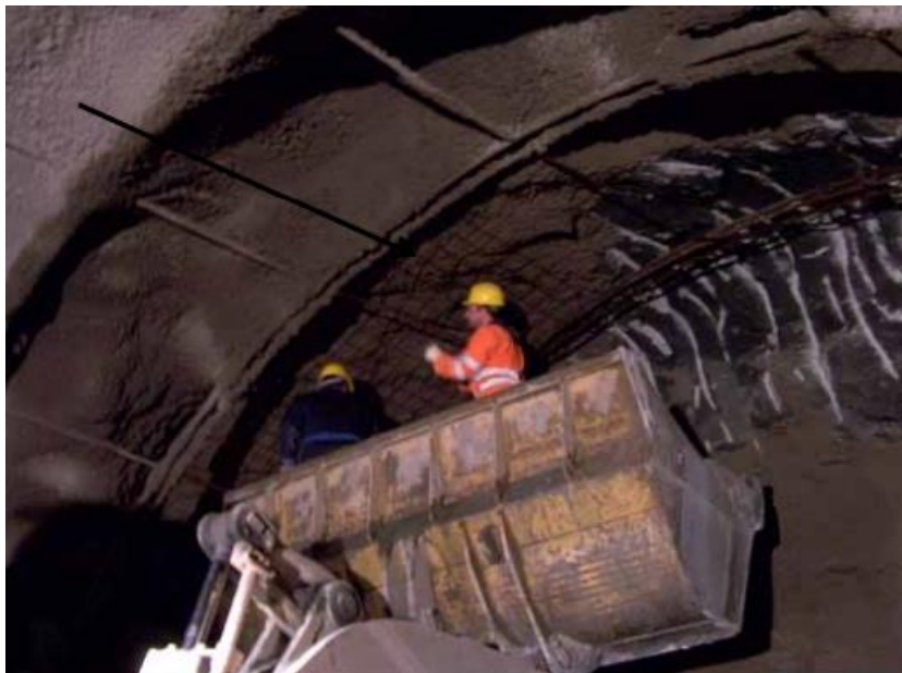
Εικόνα 3-12: Μεταλλικό πλέγμα ( Πηγή: Β.Μαρίνος, Βραχομηχανική-Σήραγγες)
