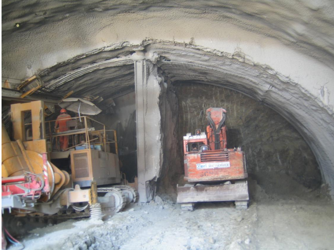
Ενδιάμεσο τοίχωμα A1 και A2 (Πηγή: 20/08/2008 ,Αττικό Μετρό Α.Ε.)
