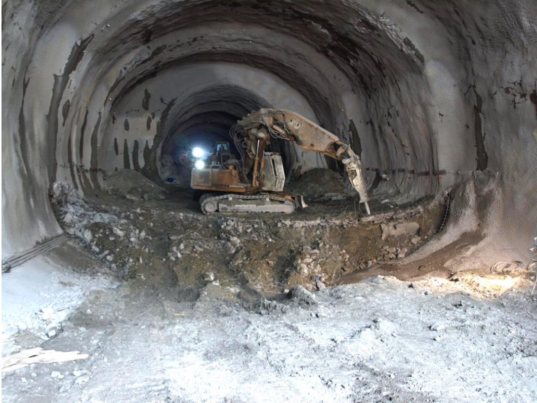
Εκσκαφή Φάσης C- Final Invert (Πηγή: 02/10/2008 ,Αττικό Μετρό Α.Ε.)
