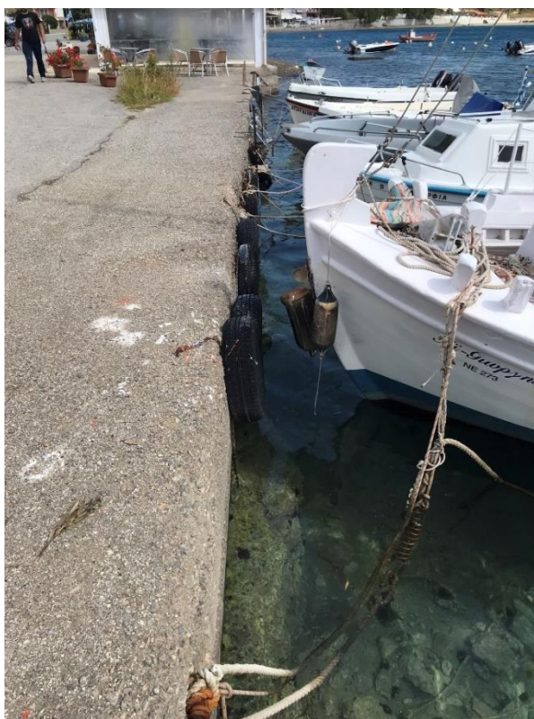
Εικόνα 5.4.3 Αποψη της ανωδομής του κρηπιδώματος επί της ακτογραμμής
