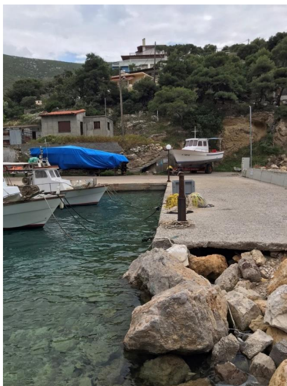
Εικόνα 5.3.8 Απόθεση σκαφών επί της ανωδομής
