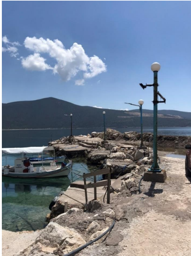
Εικόνα 5.8.2 Άποψη μορφής κρηπιδώματος με εσοχές και εξοχές
