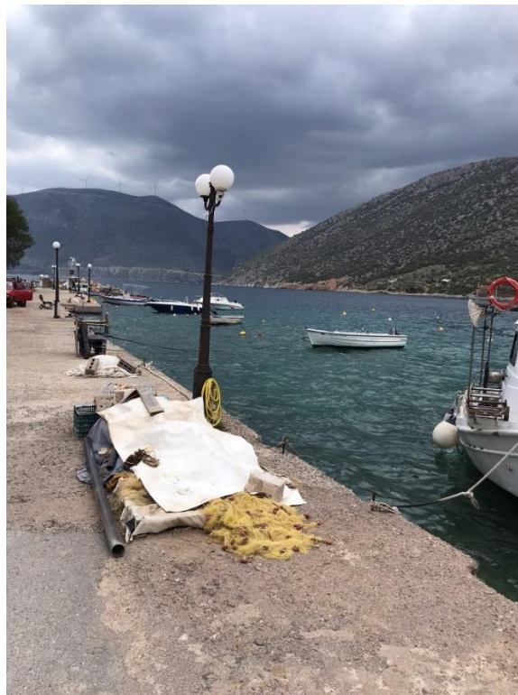
Εικόνα 5.3.7 Παράθεση αλιευτικού εξοπλισμού επί της ανωδομής
