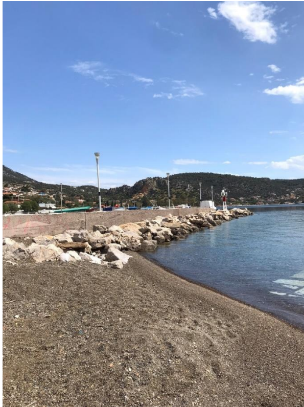
Εικόνα 5.4.1 Εξωτερική άποψη θωράκισης και τοιχίου σκυροδέματος
