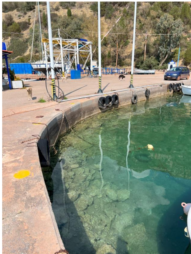
Εικόνα 5.9.13 Ρηχός πυθμένας πλησίον κεντρικού κρηπιδώματος
