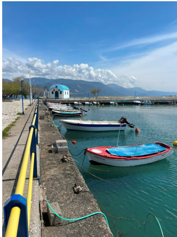
Εικόνα 5.26.1 Άποψη κεντρικού κρηπιδώματος
