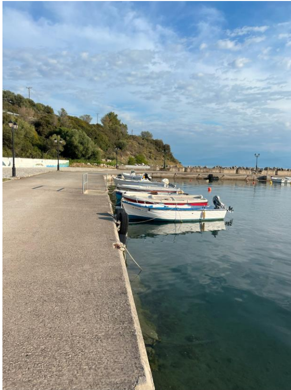
Εικόνα 5.18.2 Άποψη κεντρικού κρηπιδώματος και υπήνεμου μώλου στο βάθος
