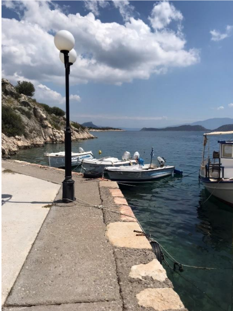
Εικόνα 5.6.3 Ιστοί φωτισμού ανωδομής
