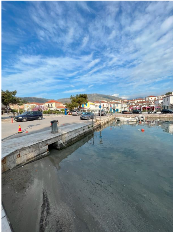
Εικόνα 5.16.6 Προσάμμωση μεταξύ κεντρικού και νότιου κρηπιδώματος
