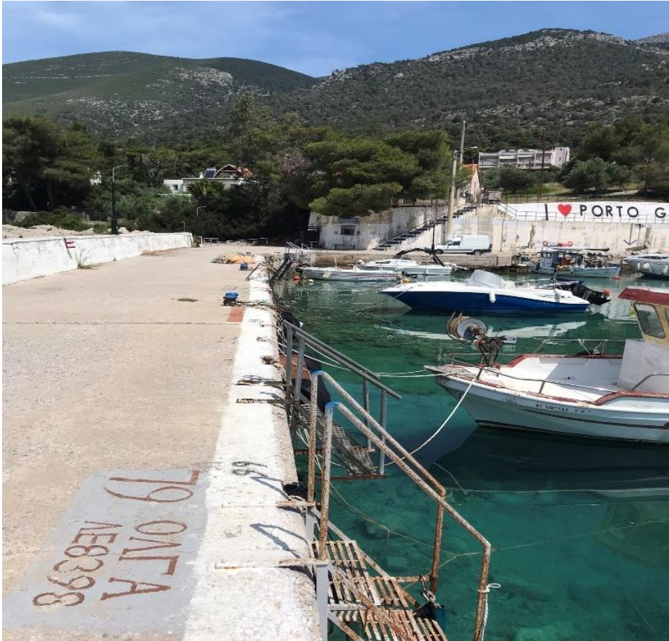
Εικόνα 5.2.6 Άποψη εξοπλισμού ανωδομής
