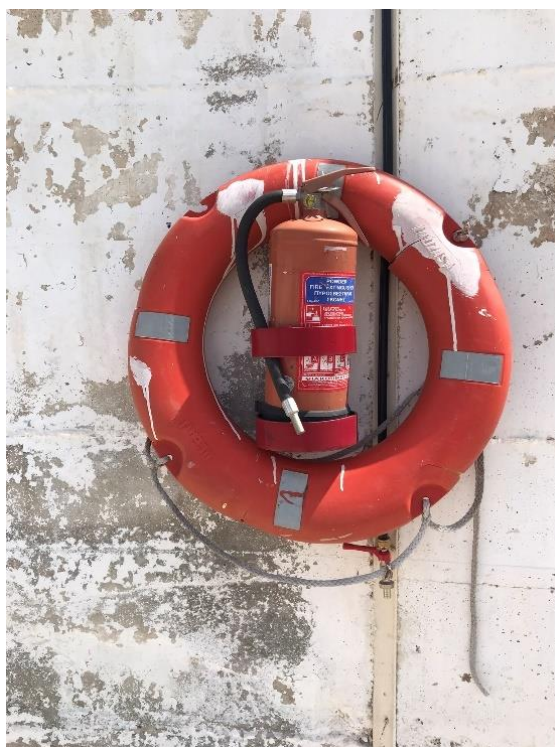
Εικόνα 5.2.7 Πυροσβεστήρας ξηράς κόνεως
