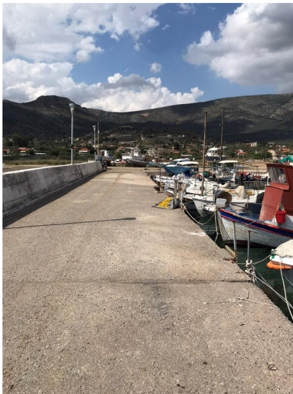
Εικόνα 5.4.2 Άποψη της ανωδομής και του τοιχίου του βραχίονα
