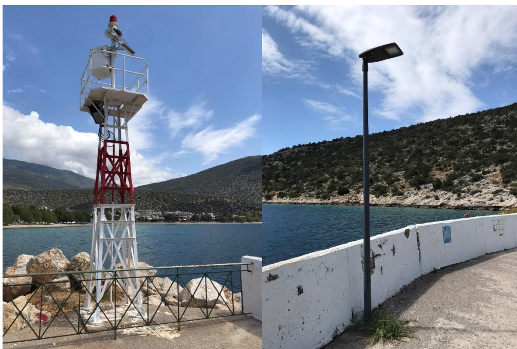
Εικόνα 5.7.3 Φάρος ακρομώλιου (αριστερά) και ιστός φωτισμού (δεξιά)
