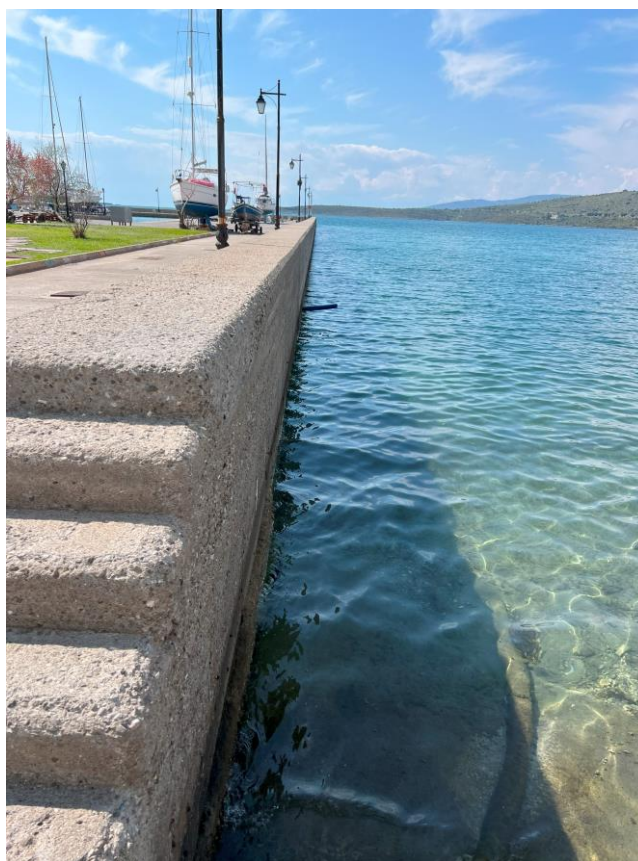
Εικόνα 5.13.1 Αποψη εξωτερικής όψης κατακόρυφου μετώπου του προσήνεμου μώλου
