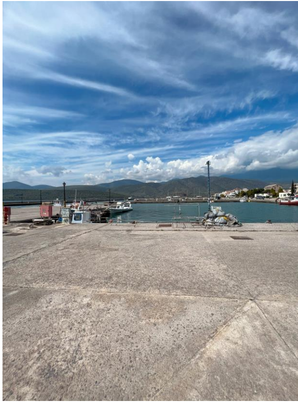
Εικόνα 5.13.12 Άποψη του προβλήτα εισόδου της μαρίνας
