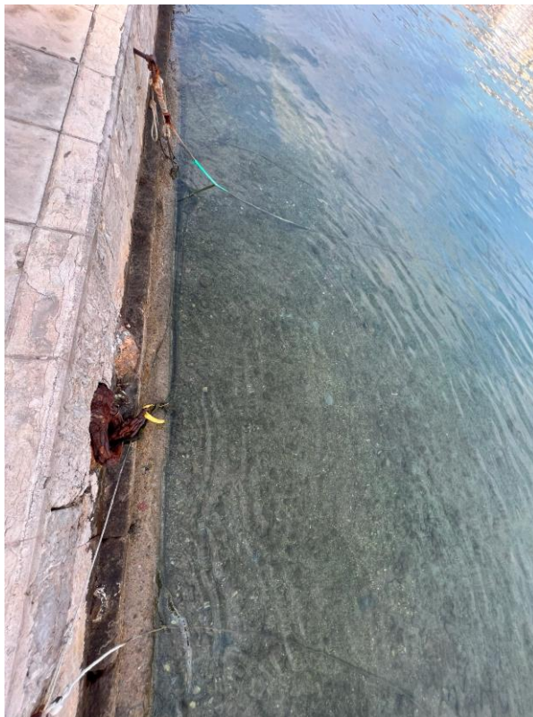
Εικόνα 5.16.7 Ρήξη κατά μήκος του νότιου κρηπιδώματος
