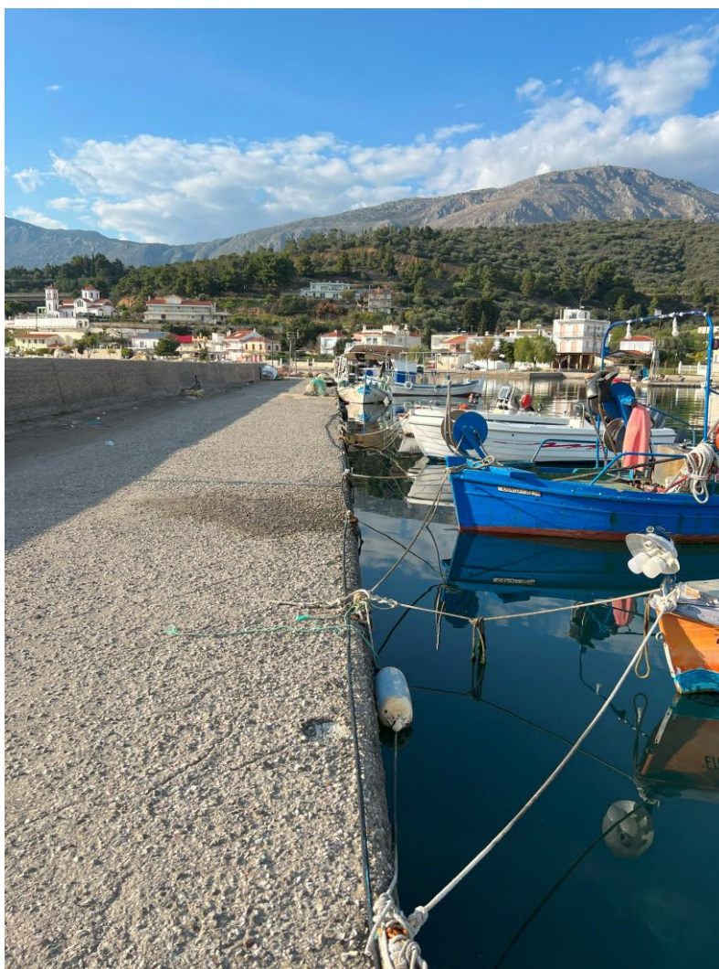
Εικόνα 5.19.2 Άποψη εξοπλισμού ανωδομής
