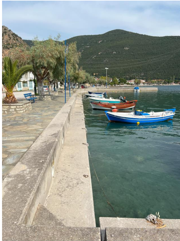
Εικόνα 5.21.1 Άποψη ανωδομής κεντρικού κρηπιδώματος
