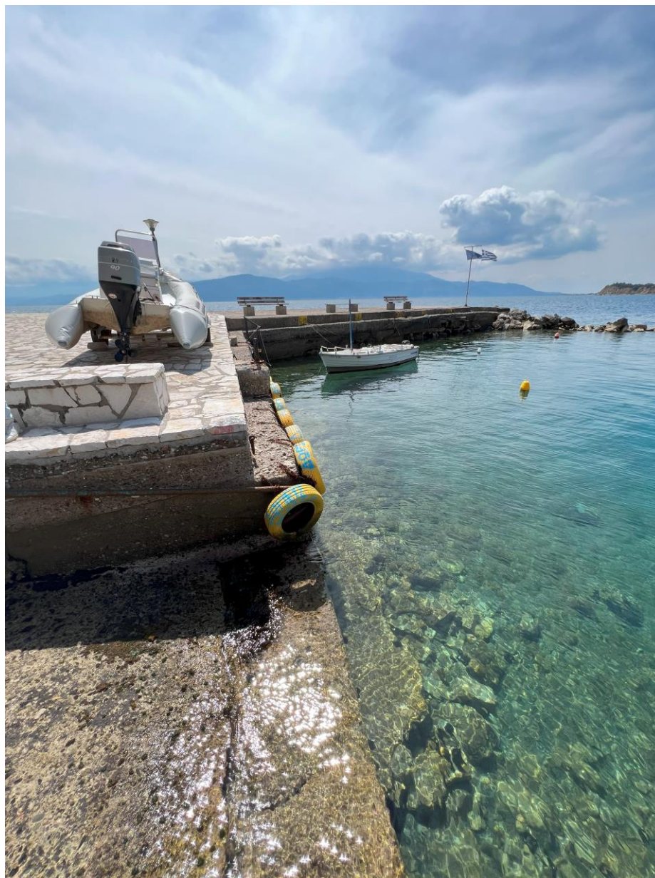
Εικόνα 5.25.4 Απότομη λήξη της ράμπας με απουσία ύφαλου τμήματος
