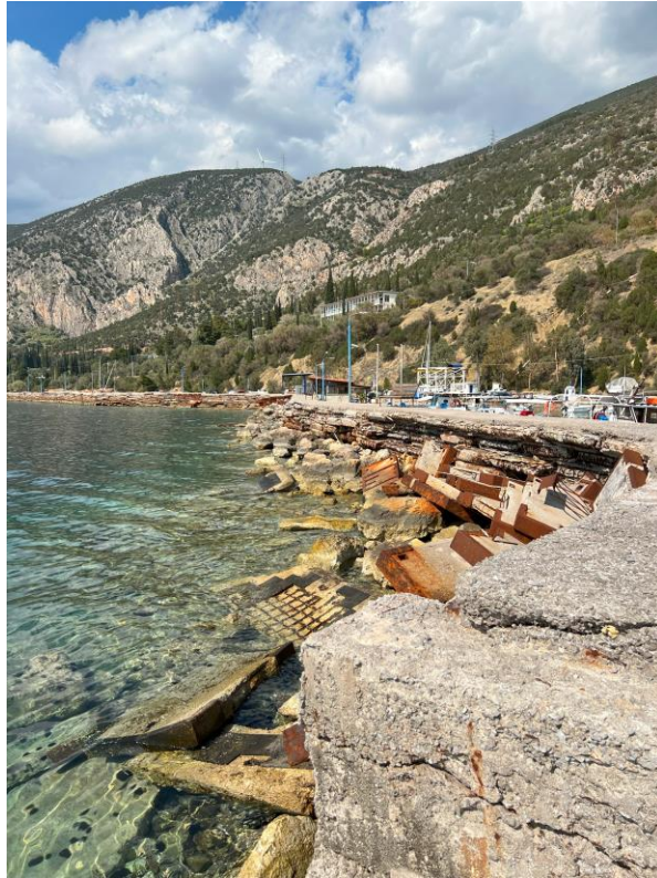
Εικόνα 5.9.9 Άποψη εξωτερικής παρειάς νότιας λιμενολεκάνης
