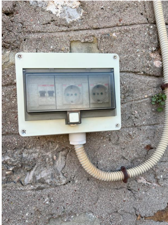
Εικόνα 5.27.2 Πίνακας λειτουργίας φωτισμού
