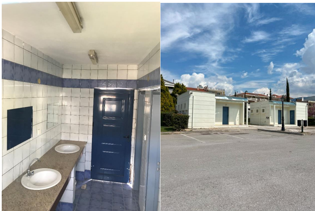
Εικόνα 5.13.11 Άποψη εσωτερικού και εξωτερικού περιβάλλοντος χώρων υγιεινής
