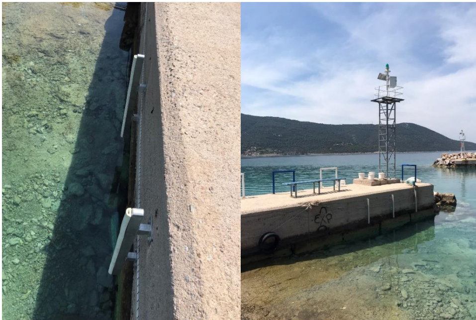
Εικόνα 5.2.5 Προσκρουστήρες υπήνεμου μώλου
