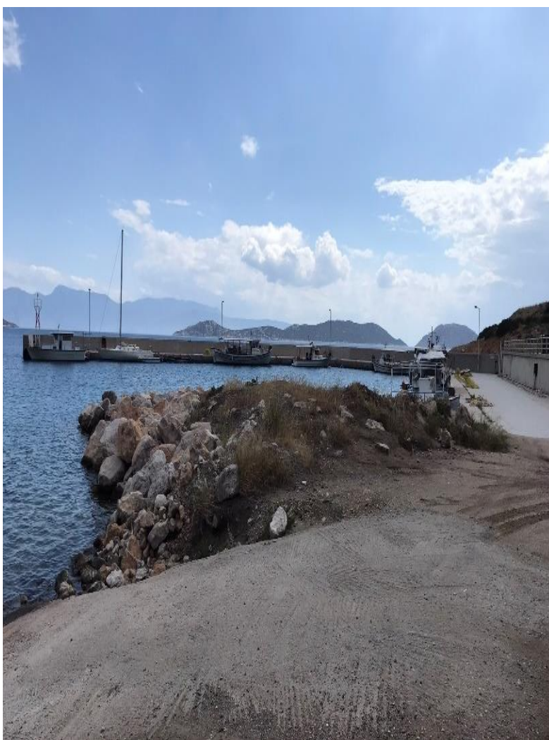
Εικόνα 5.5.4 Ράμπα ανέλκυσης - καθέλκυσης σκαφών
