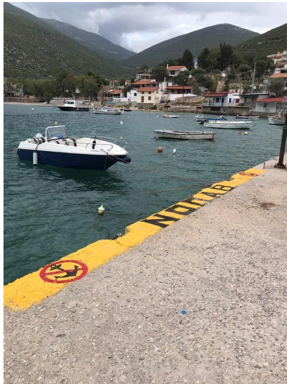
Εικόνα 5.3.3 Σήμανση απαγόρευσης κατάληψης θέσης ελλιμενισμού
