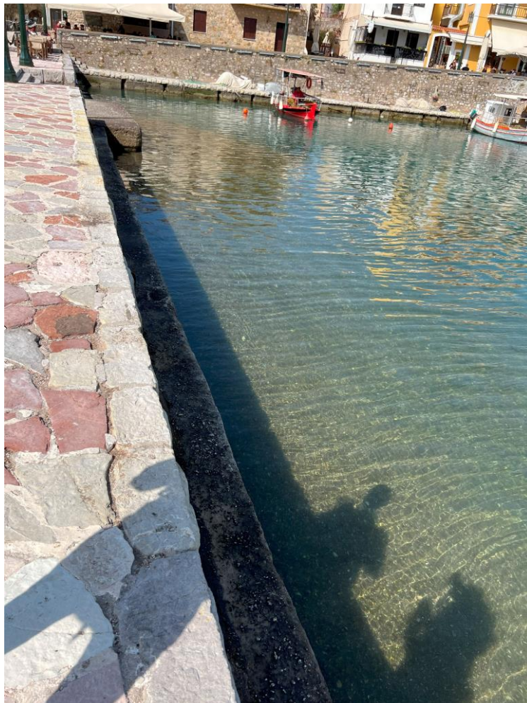
Εικόνα 5.27.5 Αδυναμία χρήσης κρηπιδώματος λόγω ρηχού πυθμένα
