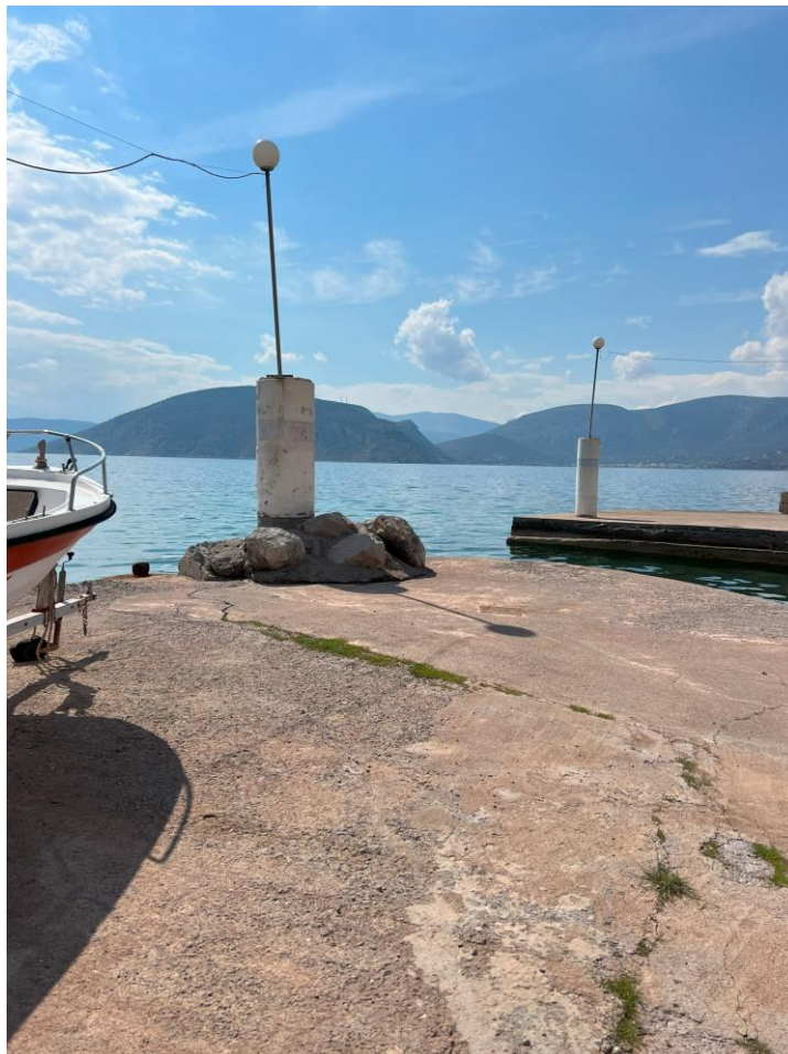
Εικόνα 5.9.11 Φωτιστικά σώματα εισόδου νότιας λιμενολεκάνης
