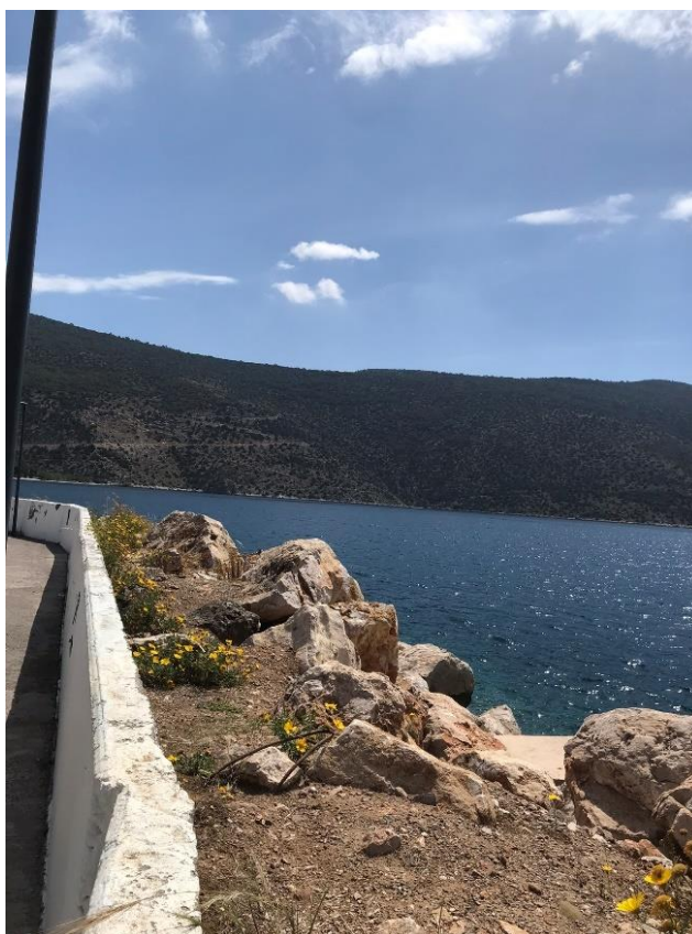
Εικόνα 5.7.1 Αποψη εξωτερικής θωράκισης και τοιχίου σκυροδέματος
