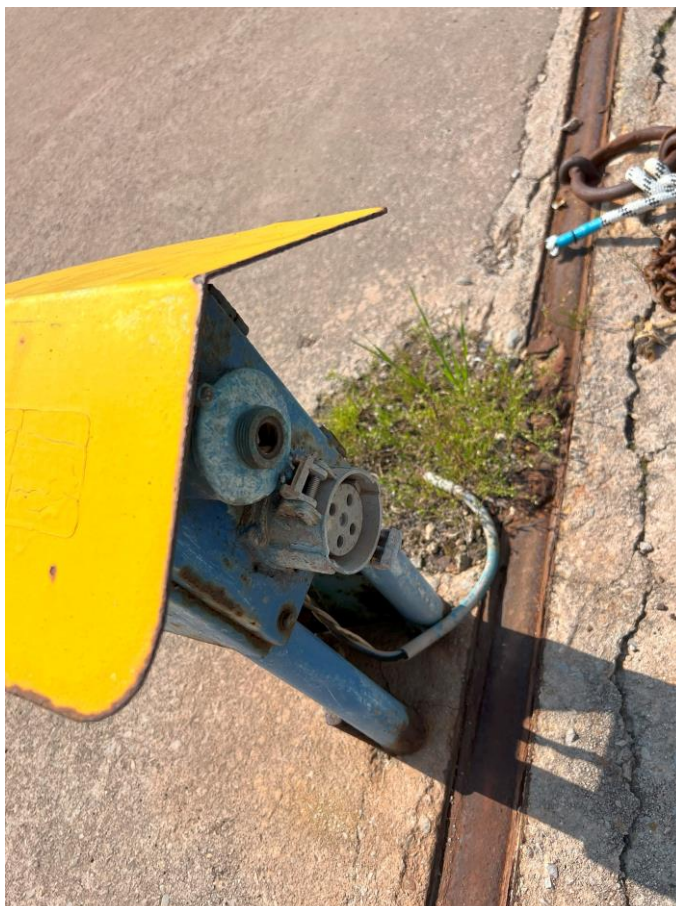
Εικόνα 5.9.6 Ερμάριο παροχής ρεύματος και θέση φωτισμού
