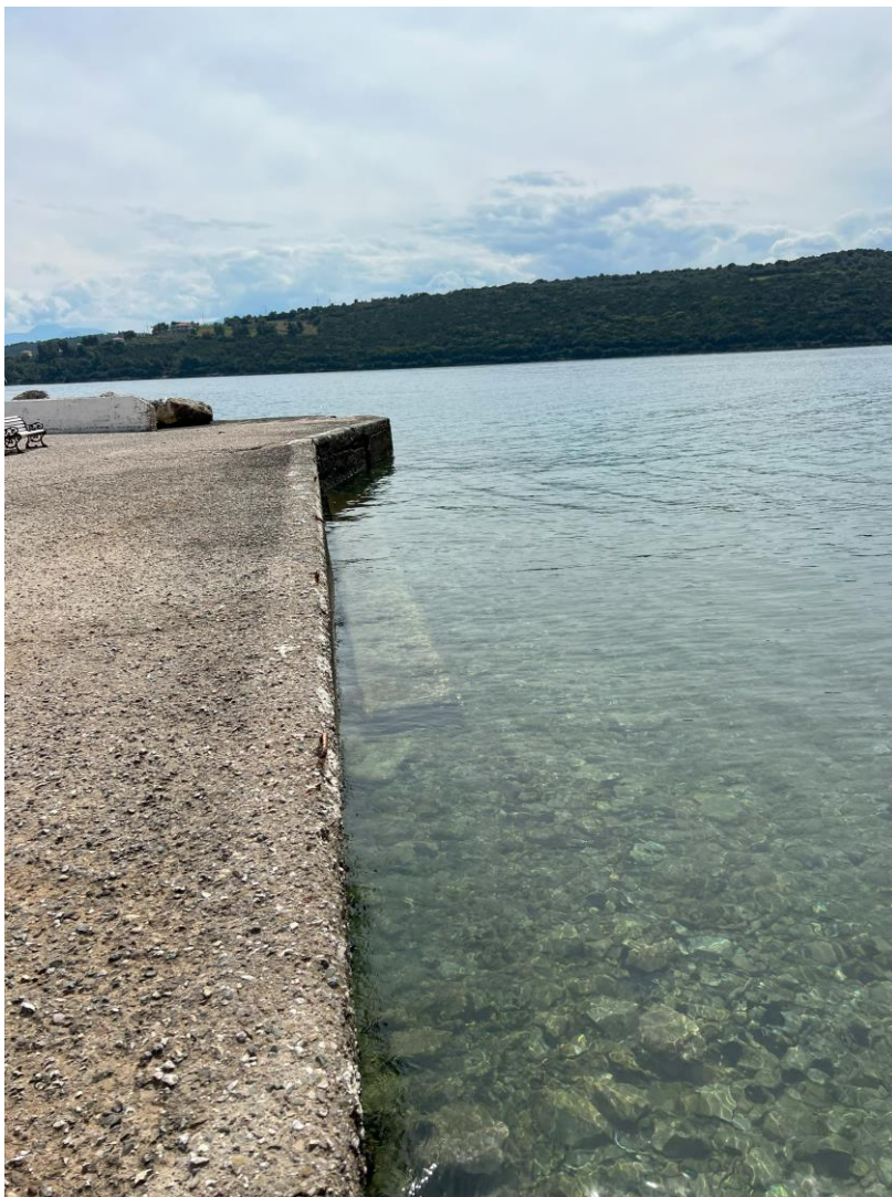
Εικόνα 5.23.2 Αδυναμία χρήσης θέσεων λόγω ρηχού πυθμένα
