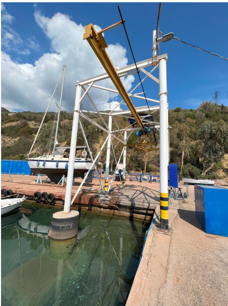
Εικόνα 5.9.1 Μεταλλικό δικτύωμα και γερανός Αλιευτικού Καταφυγίου Αγίου Νικολάου Διστόμου
