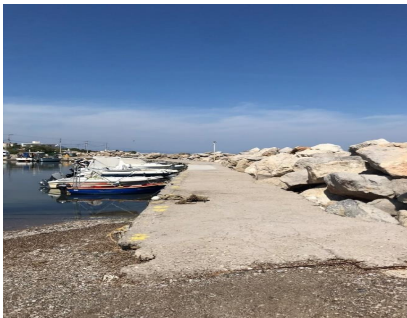
Εικόνα 5.1.1 Άποψη θωράκισης και ανωδομής προσήνεμου μώλου
