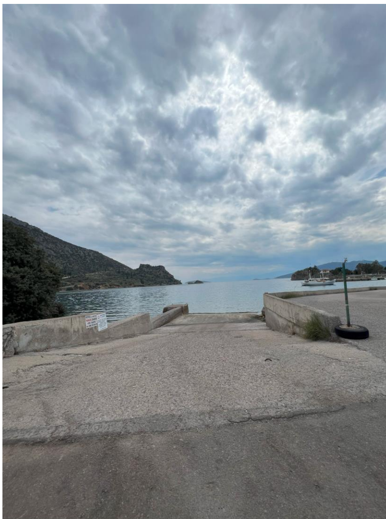
Εικόνα 5.11.1 Ράμπα ανέλκυσης - καθέλκυσης σκαφών
