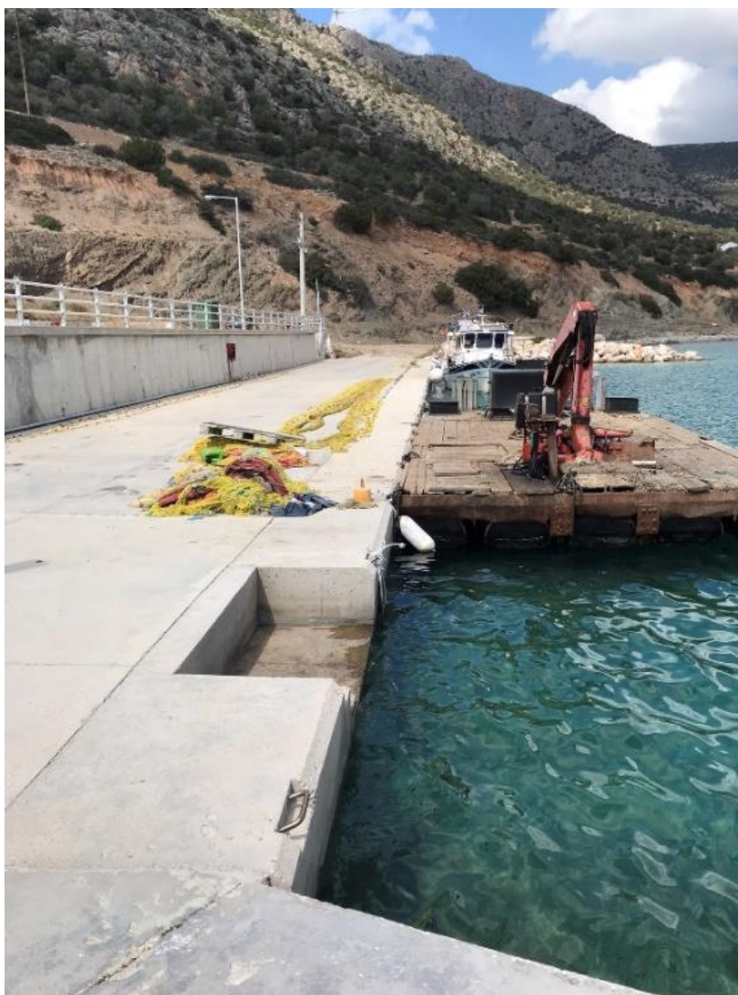
Εικόνα 5.5.5 Άποψη της ανωδομής, των λαβών πρόσδεσης και του κλιμακοστασίου
