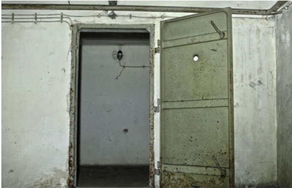
Εικόνα 3: Ειδική χαλύβδινη θυρίδα καταφυγίου για προστασία απο εισροή αερίων Πηγή: Κορίμης Κ. (2017), σελ. 88
