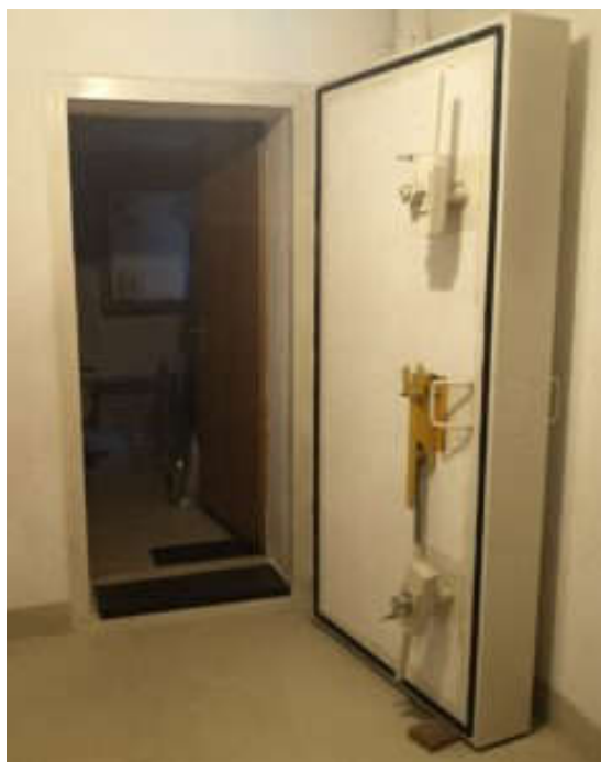
Εικόνα 23:Θωρακισμένη πόρτα σε ιδιωτικό καταφύγιο της Ελβετίας Πηγή: https://swissfederalism.ch/en/fallout-shelters-emergency-management-switzerland/ (πρόβαση: 27 Απριλίου 2023)
