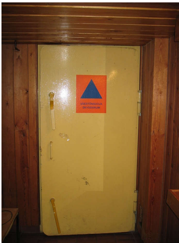
Εικόνα 27: Θωρακισμένη πόρτα σε οικιακό καταφύγιο στη Φινλαδία Πηγή: https://en.wikipedia.org/wiki/Civil_defence_in_Finland
