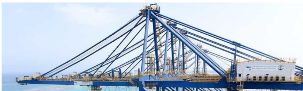
Εικόνα 4-2: Φωτογραφία άνω τμήματος γερανού τύπου STS (από https://rsgt.com )
