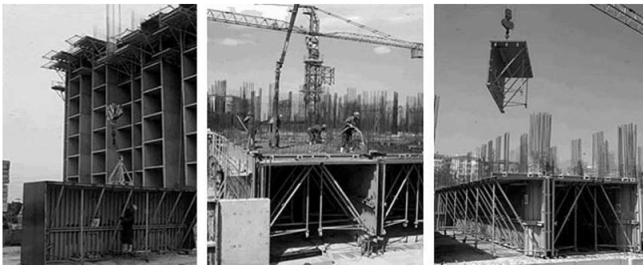
Εικ. 1-1: Κατασκευή κτιρίων Tunnel Form, πηγή: (Balkaya, Karagoz, & Gunal, 2017)
