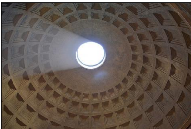
Εικ. 2-1: Πάνθεον της Ρώμης, θόλος κατασκευασμένος με ελαφρά αδρανή
