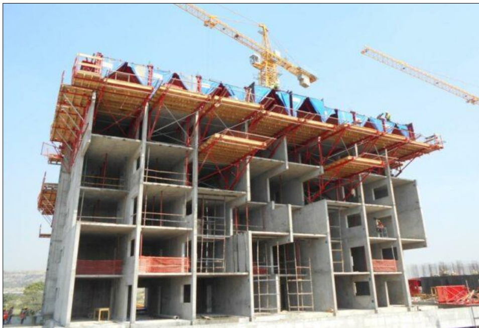
Εικ. 1-8: Κτίριο Tunnel form κατά την φάση κατασκευής, πηγή: www.constrofacilitator.com
