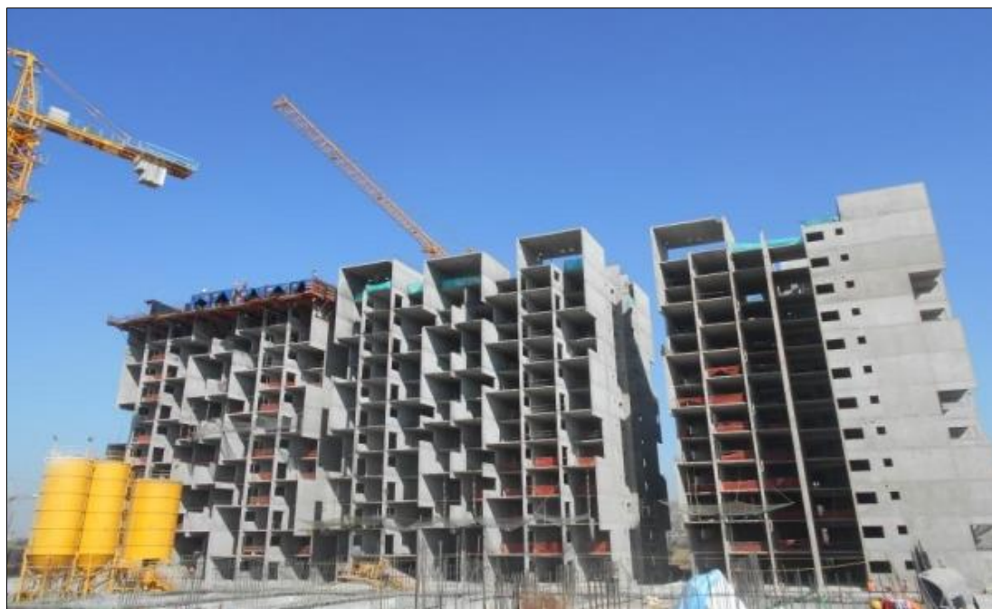
Εικ. 1-9: Κατασκευή κτιρίου Tunnel Form στο Πούνε της Ινδίας, www.rohanbuilders.com
