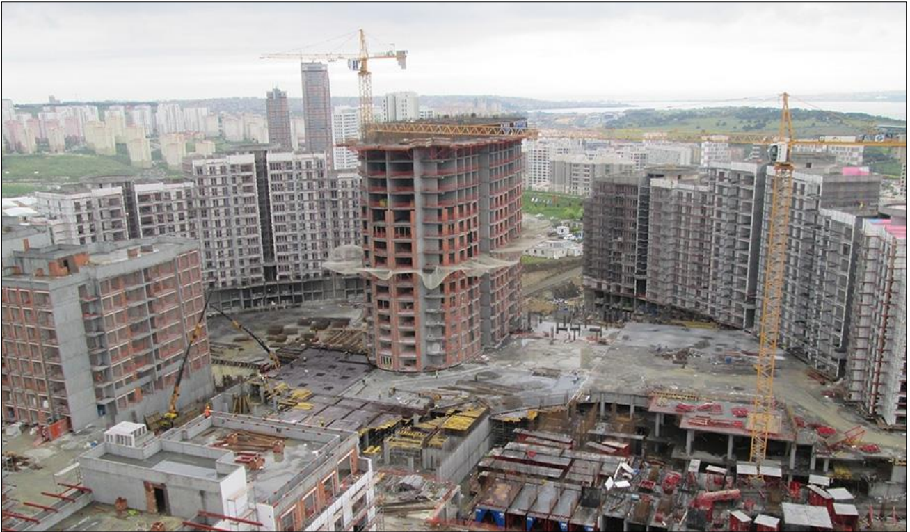
Εικ. 1-11: Κατασκευή κτιρίων με τη μέθοδο tunnel form στην Κωνσταντινούπολη, Tema Istanbul Project, πηγή: www.mesaimalat.com.tr
