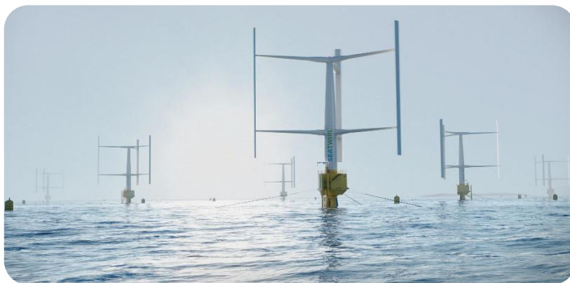
Εικόνα 4: Πλωτή ανεμογεννήτρια στη Νορβηγία 1MW κατακόρυφου άξονα (Πηγή ιστοσελίδας: https://seatwirl.com/news/new-video-from-seatwirl/ )
