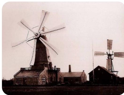
Εικόνα 2: Ανεμογεννήτρια La Cour (Πηγή: Κάραλης, 2021)
