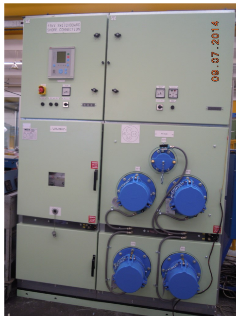
Εικόνα 2.3.3.1 Πίνακας διανομής ξηράς
