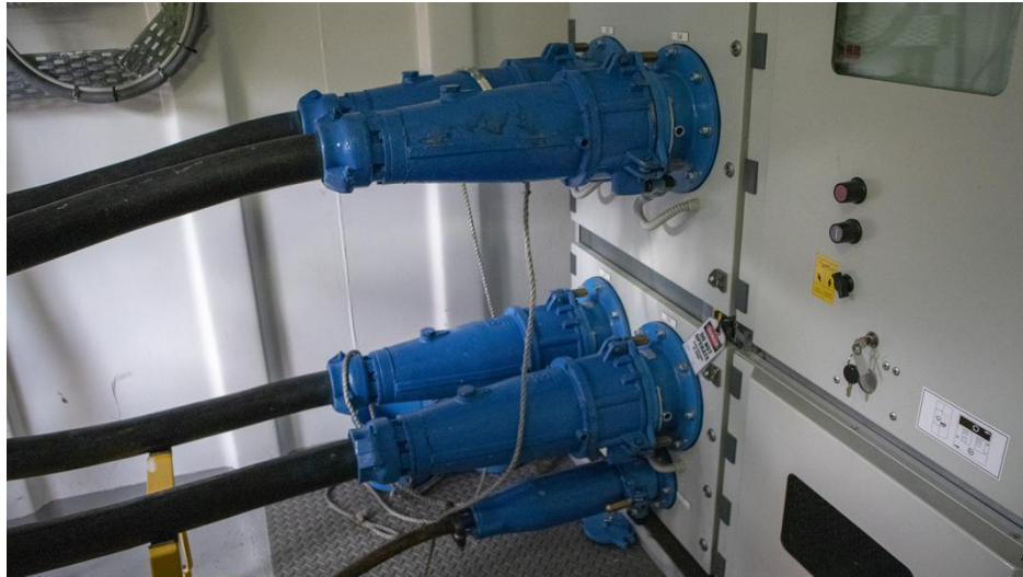
Εικόνα 2.3.2.2 Καλώδια για τη λειτουργία του Cold Ironing
