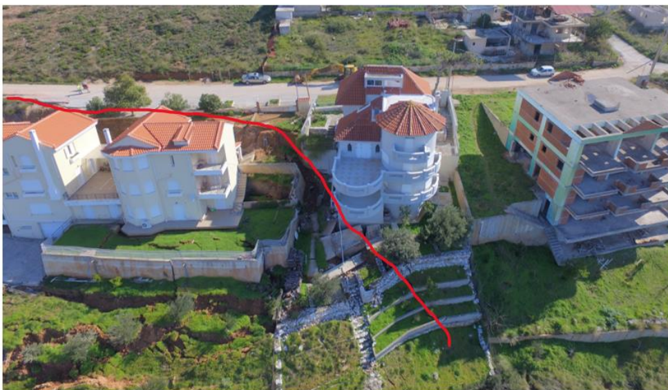
Εικόνα 1.10: Το όριο της κατολίσθησης (κόκκινη γραμμή) το οποίο διέρχεται από τον αύλιο χώρο της τρίτης κατοικίας η οποία υπέστη στροφή
