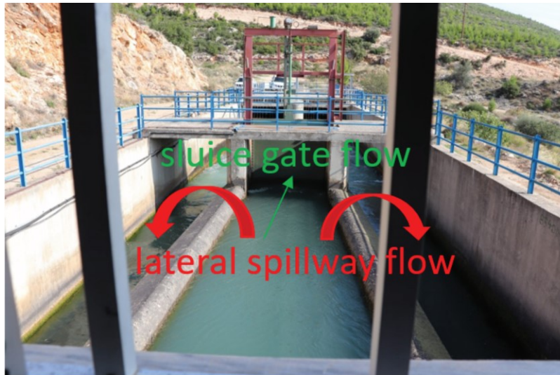
Εικόνα 2.7: Διάταξη ρυθμιστή Λ.
