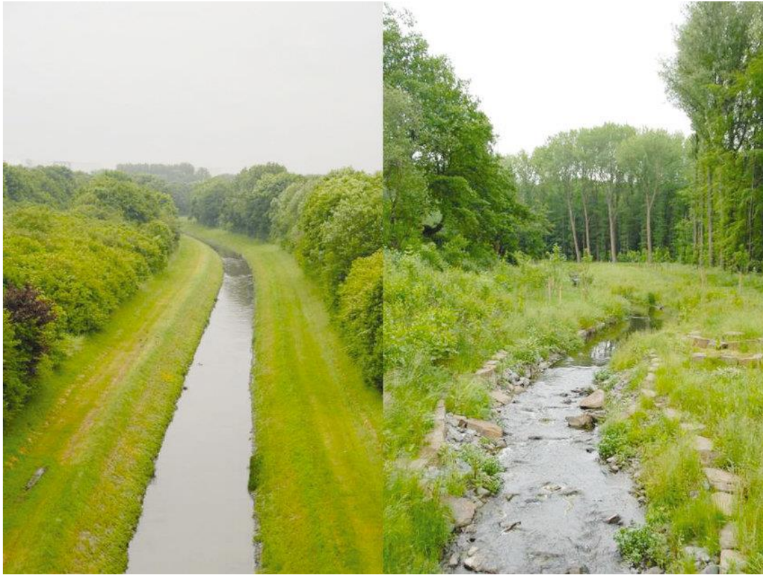
Φωτογραφία 8: Ο ποταμός Emscher πριν (αριστερά) και μετά (δεξιά) τις εργασίες αποκατάστασής του (Gruehn, 2013)
