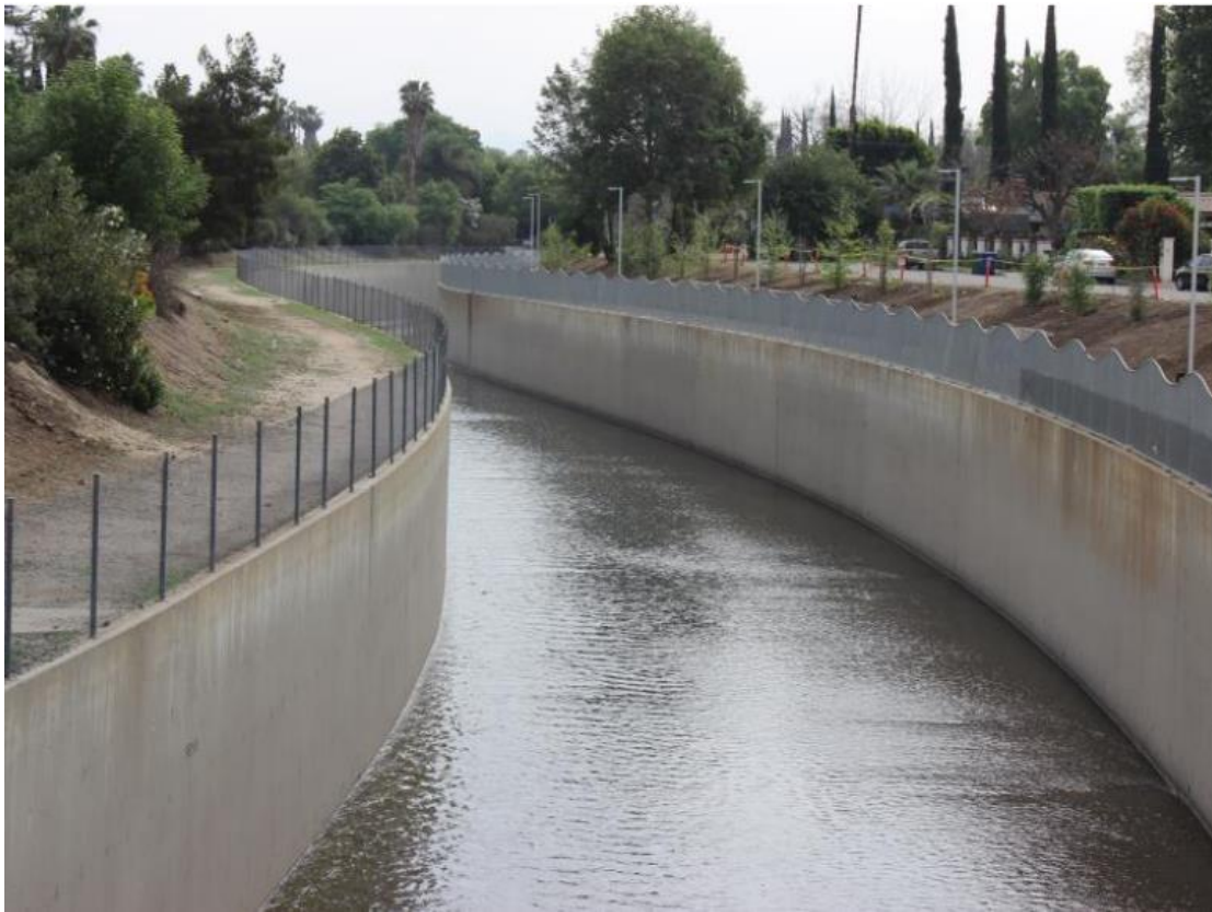
Φωτογραφία 12: Παράδειγμα διατομή ποταμού από σπλισμένο σκυρόδεμα ( https://megalorema.gr/ )
