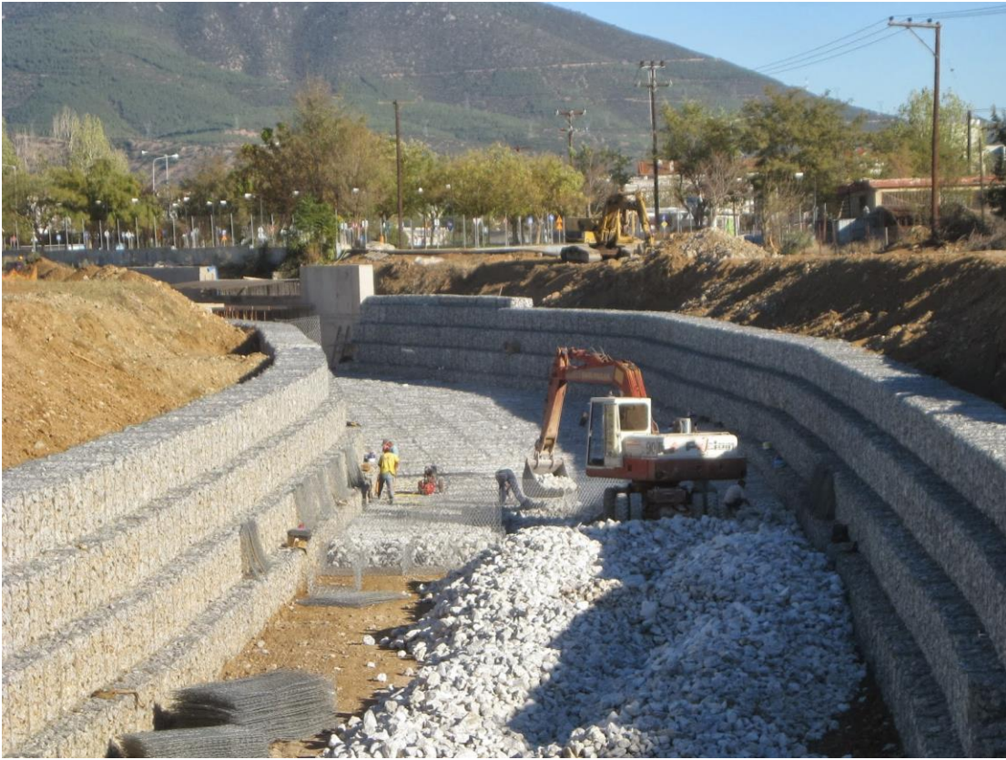
Φωτογραφία 13: Παράδειγμα διατομής ποταμού από λιθοπλήρωτα συρματοκιβώτια. ( https://megalorema.gr/ )
