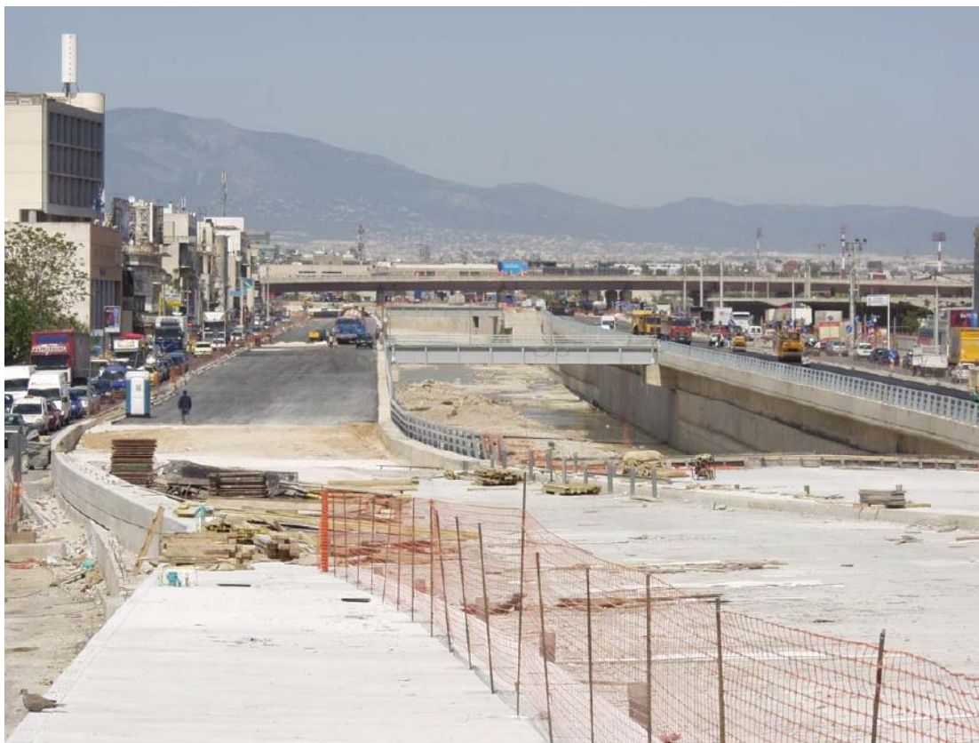
Εικόνα 7: Έργα διευθέτησης κάτω ρου Κηφισού (Λαζαρίδης κ.ά., 2008)
