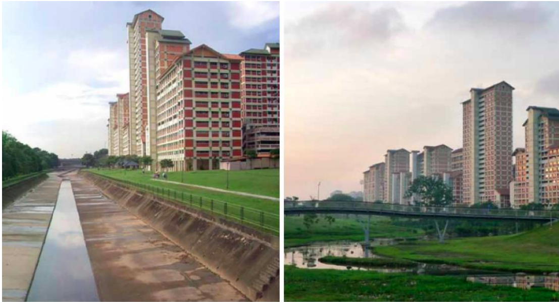
Φωτογραφία 5: Πριν (αριστερά) και μετά (δεξιά) την φυσική αποκατάσταση κοίτης με μεθόδους bioengineering σε ρέμα της Σιγκαπούρης ( https://www.governmentarchitect.nsw.gov.au/ )
