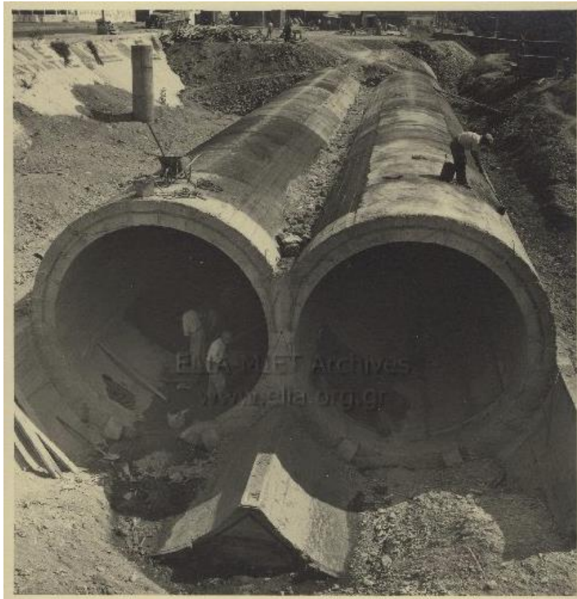
Φωτογραφία 4: Εργασίες υπογειοποίησης του Ιλισσού ποταμού ( https://www.searchculture.gr/ )
