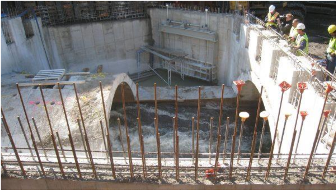
Φωτογραφία 9: Οι εργασίες αποκάλυψης του ποταμού Saw Mill ( https://groundworkusa.org/ )
