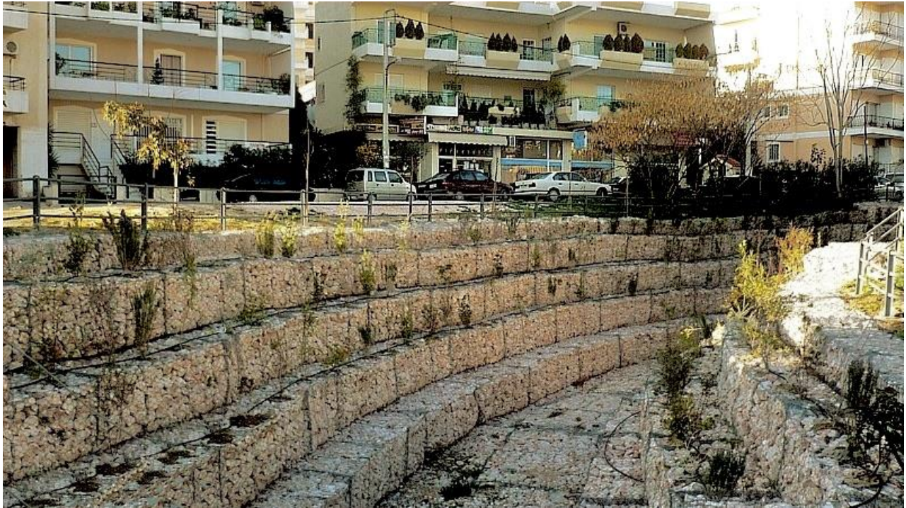
Φωτογραφία 3: Διευθετημένο με συρματοκιβώτια Ρέμα Παλλήνης ( https://el.wikipedia.org/ )
