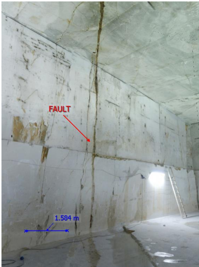
Εικόνα 21: Ρήγμα, η στάση του οποίου χρησιμοποιήθηκε για την αξιολόγηση της αξιοπιστίας των μεμονωμένων μετρήσεων με φωτοερμηνεία σε VR-προοπτική άποψη, η γραμμή κλίμακας είναι μόνο ενδεικτική.
