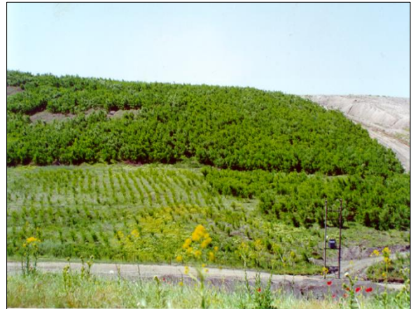
Εικόνα 2: Τυπικό δείγμα αποκατάστασης πρανών απόθεσης με δασικά είδη (Πηγή: ΔΕΗ- Γενική Διεύθυνση Λιγνιτικής Παραγωγής)
