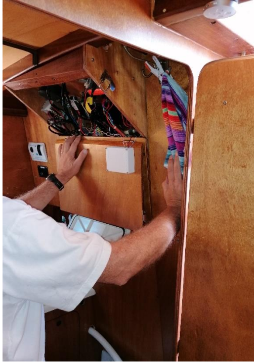
Εικόνα 4.34 – Τοποθέτηση Module D
