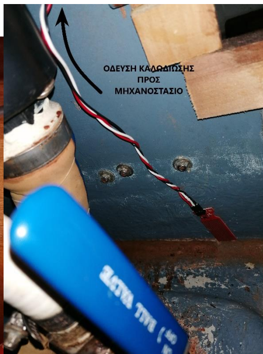
Εικόνες 4.31 – 4.32 - Αριστερά η μέτρηση θερμοκρασίας υγρασίας στον κύριο χώρο και δεξιά ο αισθητήρας κατάκλισης στο αντλιοστάσιο του WC
