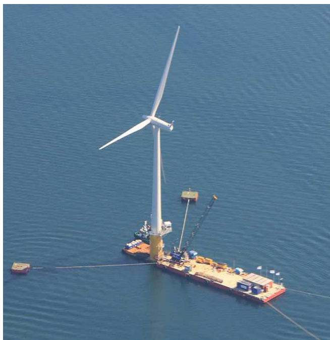
Εικόνα 11. Hywind (Spar buoy), η πρώτη παγκόσμια πολύ-μεγαβάτ πλωτή ανεμογεννήτρια (Skaare et al, 2010).
