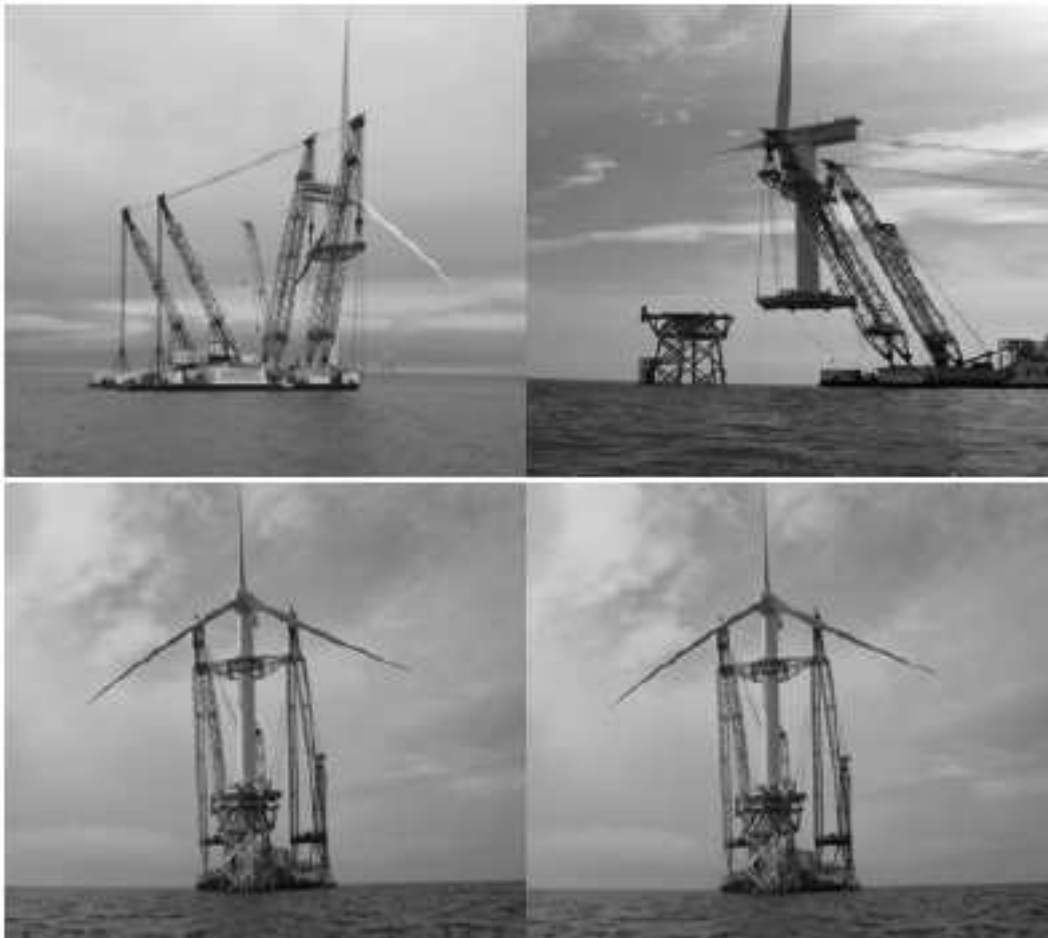
Εικόνα 10. Κατασκευή έδρασης Jacket (διαδικασία ανύψωσης ανεμογεννητριών στο Beatrice) (Wang and Bai, 2010).
