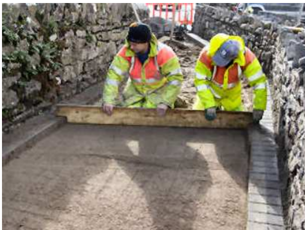
Εικόνα 4.23: Τελική συμπύκνωση με χρήση ξύλινου πήχη (Step-by-Step Guide to Block Pavement Construction)
