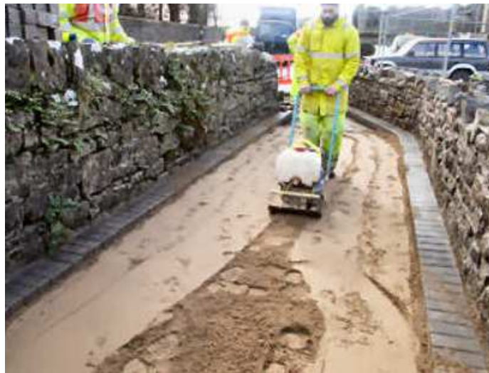
Εικόνα 4.22: Συμπύκνωση άμμου με συμπιεστή δονούμενης πλάκας (Step-by-Step Guide to Block Pavement Construction)
