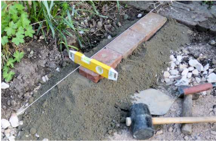
Εικόνα 4.14: Τοποθέτηση κρασπέδου (Concrete Bedded Edgings & Kerbs)
