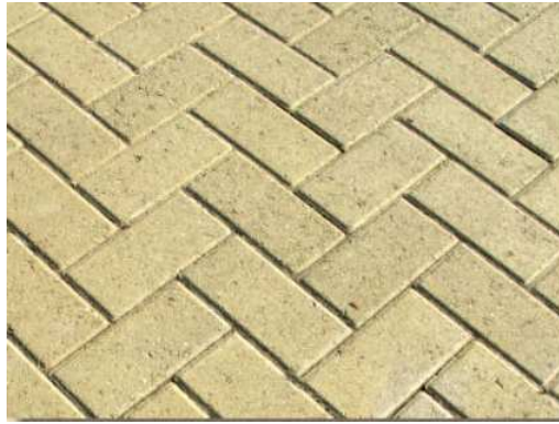
Εικόνα 3.4: Πλακόστρωση με μονόχρωμους κυβόλιθους (Block Paving - Choosing a Block or Brick Paver)
