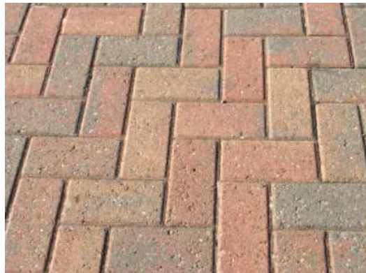
Εικόνα 3.5: Πλακόστρωση με πολύχρωμους κυβόλιθους (Block Paving - Choosing a Block or Brick Paver)
