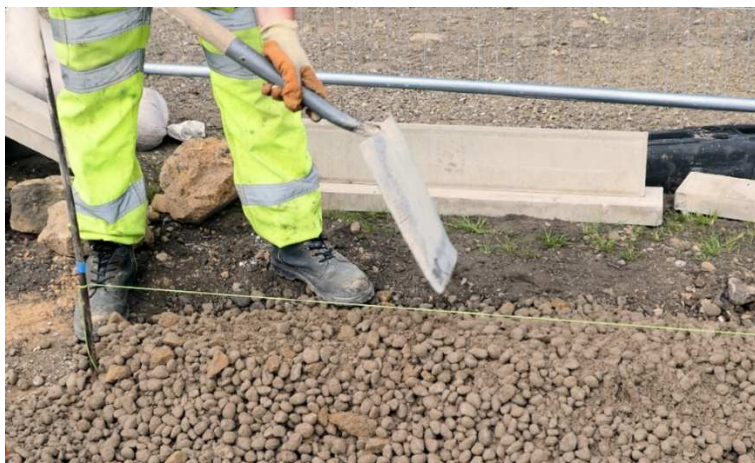
Εικόνα 4.13: Διάστρωση σκυροδέματος κλινοστρωμνής (Concrete Bedded Edgings & Kerbs)
