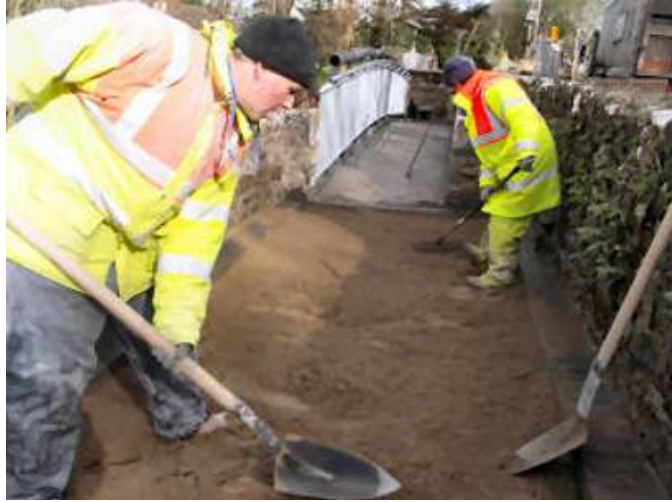
Εικόνα 4.21: Διάστρωση υλικού κλινοστρωμής (Step-by-Step Guide to Block Pavement Construction)
