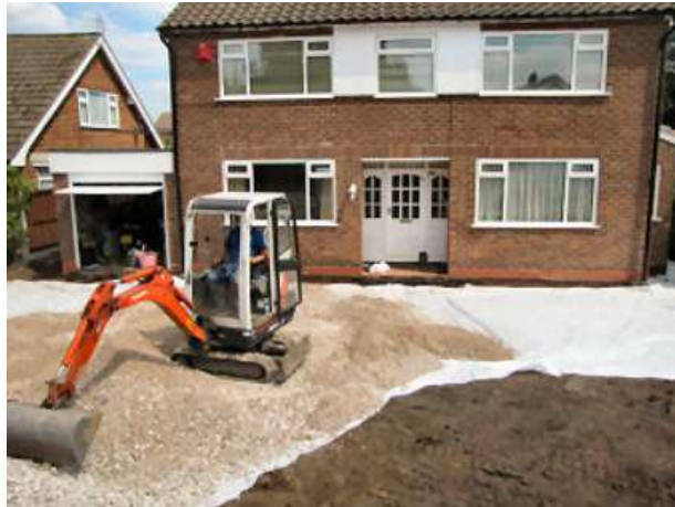
Εικόνα 4.17: Διάστρωση υλικού υπόβασης (Step-by-Step Guide to Block Pavement Construction)
