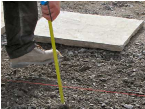
Εικόνα 4.19: Μέτρηση επιπέδου υπόβασης (Sub-bases)
