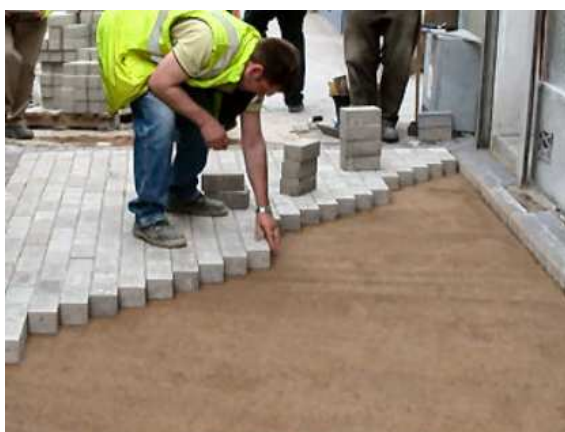
Εικόνα 4.24: Τοποθέτηση κυβόλιθων με χειρωνακτική εργασία (από προσωπικό αρχείο)
