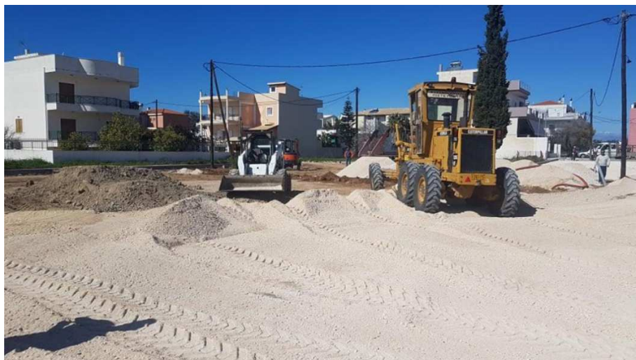
Εικόνα 6.5: Επίστρωση υλικών στρώσης εξυγίανσης (από προσωπικό αρχείο)
