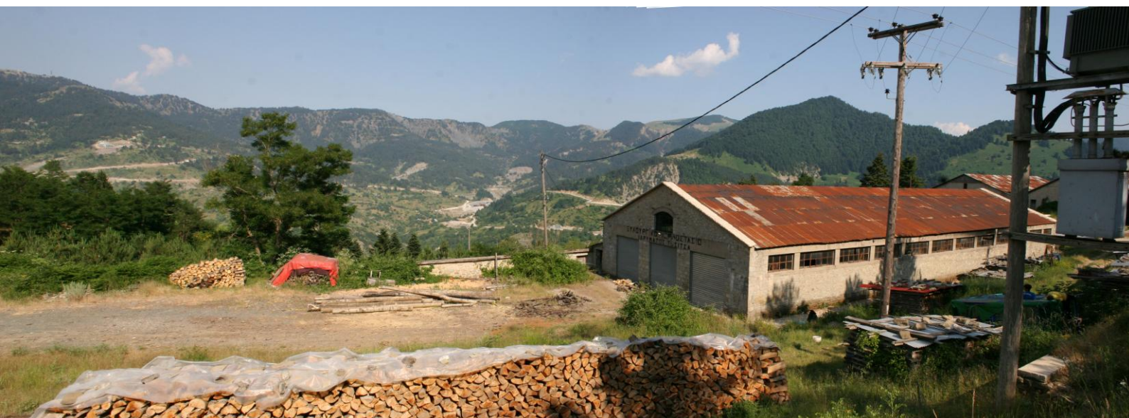
Εικόνα 39 Ξυλουργικό Εργοστάσιο Ιδρύματος Τσοίτσα
