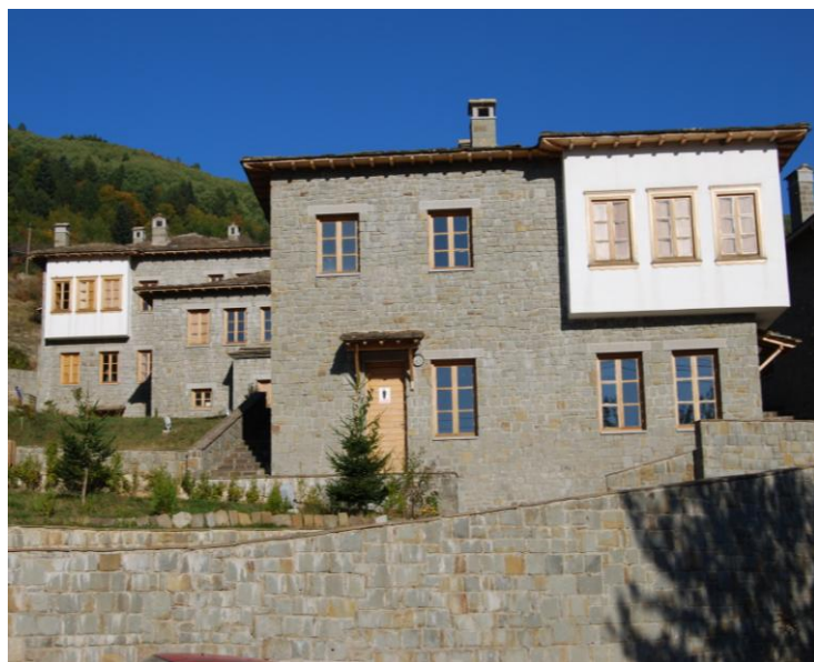
Εικόνα 41 Μετσόβιο Κέντρο Επιστημονικών Ερευνών
