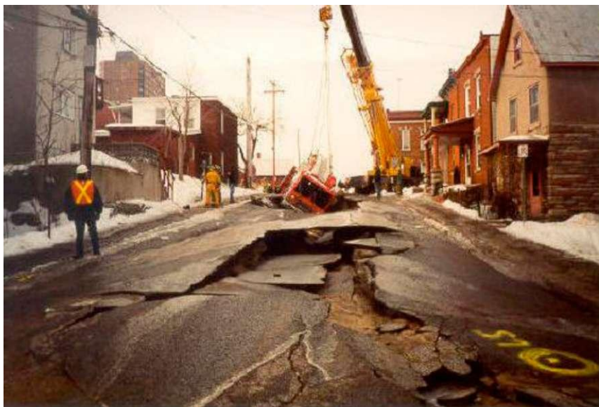
Διάβρωση Εδάφους λόγω Έντονων Θερμοκρασιακών Αλλαγών
