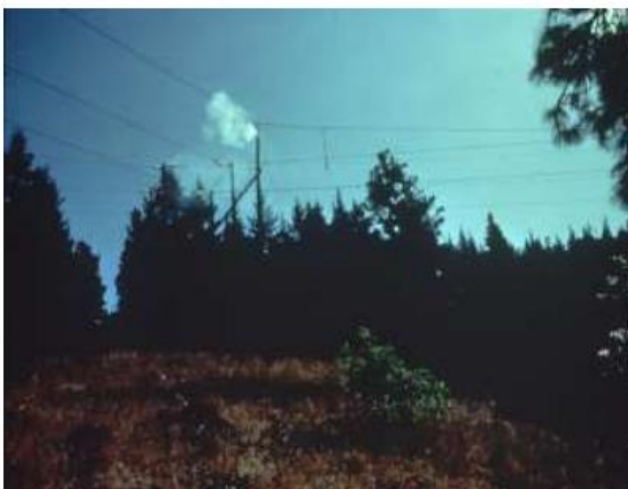
Εικόνα 8 Φωτιά από βλάβη ηλεκτρικού δικτύου
