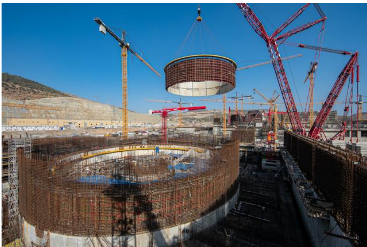
Εικόνα 2.3: Φάση κατασκευής του εργοστασίου Ακκούγιου (Πηγή: < http://www.akkuyu.com/photo-gallery >)
