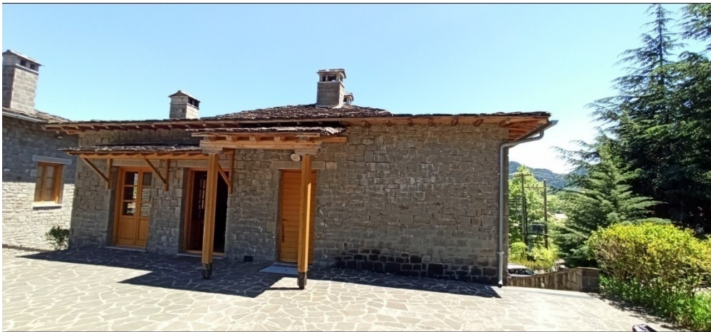
Εικόνα 4.15: Δυτική όψη του κτιρίου του εστιατορίου – κυλικείου (στάθμη +3,40 μ.)
