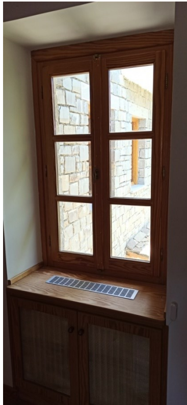
Εικόνα 4.20: Παράθυρο επί του κτιρίου ζενώνα
