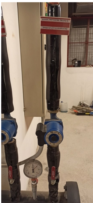
Εικόνα 4.26: Κυκλοφορητές ζεστού νερού χρήσης
