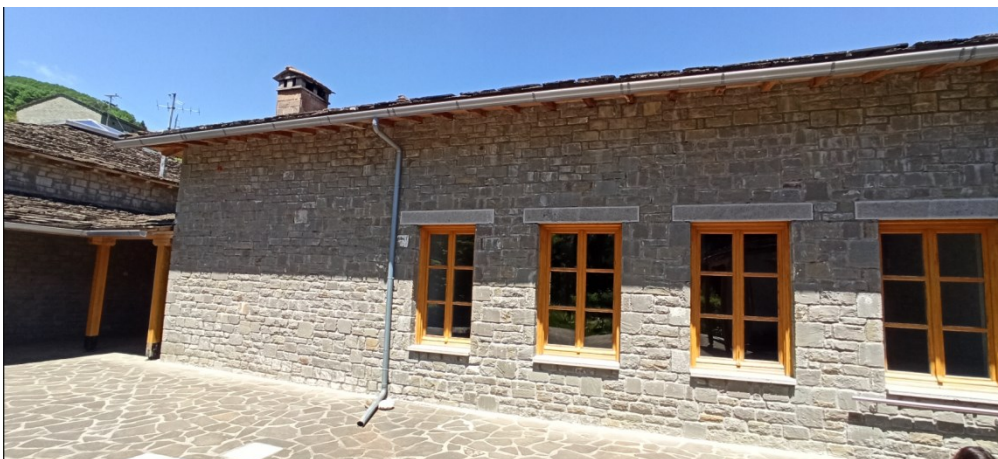
Εικόνα 4.13: Μέρος Νότιας όψης του κτιρίου υποδοχής και διοίκησης (στάθμη +3,50 μ.)
