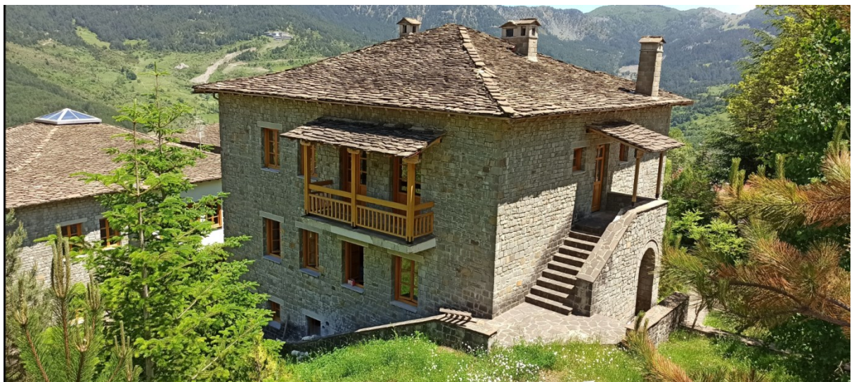
Εικόνα 4.17: Νότιο-δυτική όψη του κτιρίου του ξενώνα (στάθμη +6,65 και +9,85 μ.)
