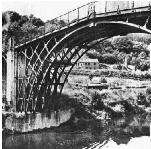
Εικόνα 4.1.1: Η πρώτη μεταλλική γέφυρα που κατασκευάστηκε στην Αγγλία. Αποτελείται από 5 ημικυκλικά παράλληλα τόξα ανοίγματος 30,5 m και ένα κατάστρωμα από χυτοσίδηρες πλάκες μήκους 7,5 m. Το βάρος της κατασκευής είναι ίσο με 378,5 τόνους [113].
