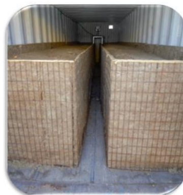
Σχήμα 33 : Εξωτερική άποψη και το περιεχόμενο των containers που θα στεγάσουν το σύστημα αποθήκευσης θερμότητας στερεής κατάστασης
