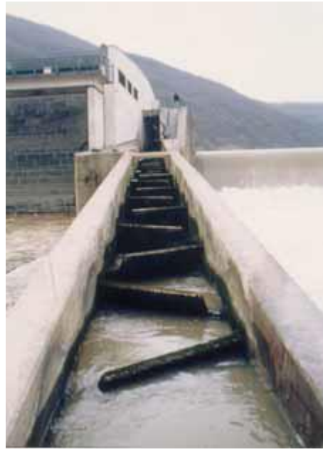
Εικόνα 2.4 ΔΙ με ρομβοειδή διάταξη πετασμάτων [10]
