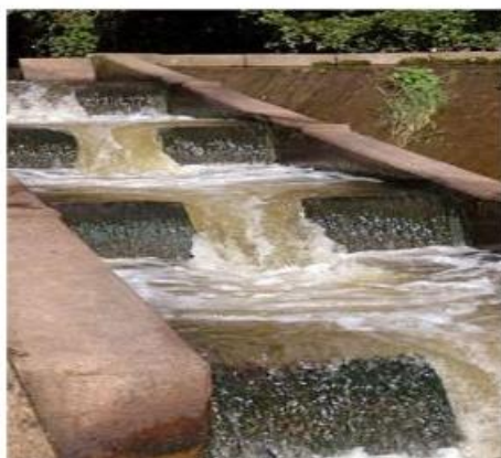
Εικόνα 2.3 ΔΙ με εγκοπές στα πετάσματα (αριστερά) και υπερχειλιστές (δεξιά) [10]
