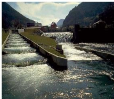
Εικόνα 2.3 ΔΙ με εγκοπές στα πετάσματα (αριστερά) και υπερχειλιστές (δεξιά) [10]
