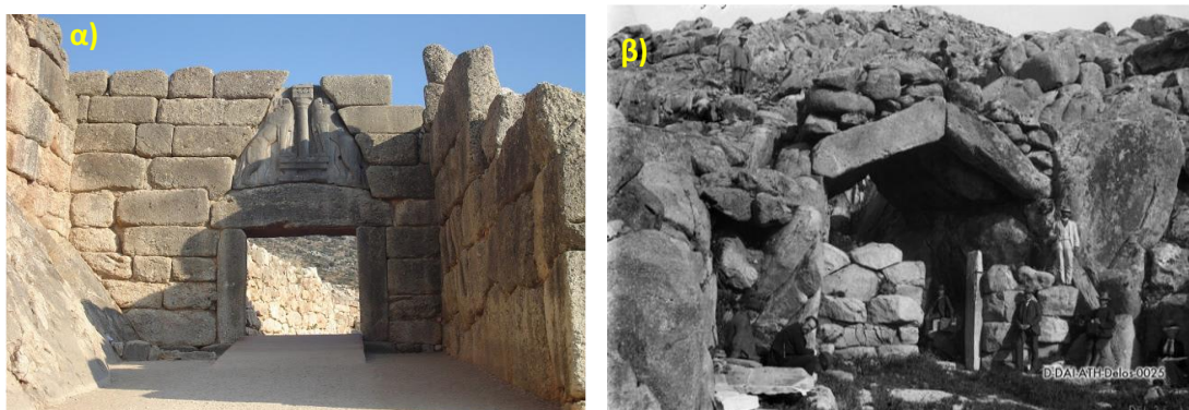
Σχήμα 4 Παραδείγματα ενός συστήματος δοκός επί στύλων (α' - η Πύλη των Λεόντων στις Μυκήνες) και ενός εκφορικού τόξου (β' - το ιερό του Ηρακλή στην Δήλο).
