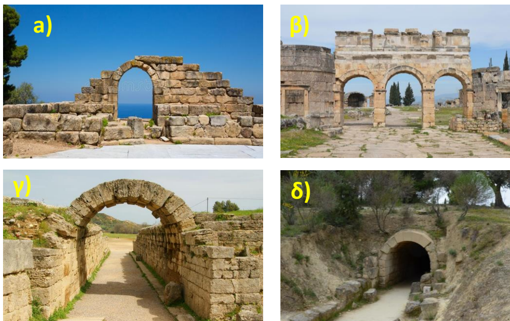
Σχήμα 1 Μερικά αντιπροσωπευτικά παραδείγματα ιστορικών μνημείων γύρω από την Μεσόγειο Θάλασσα: λίθινα τόξα στηριζόμενα σε αψιδοστάτες και κυλινδρικοί θόλοι ενσωματωμένοι στο έδαφος.
