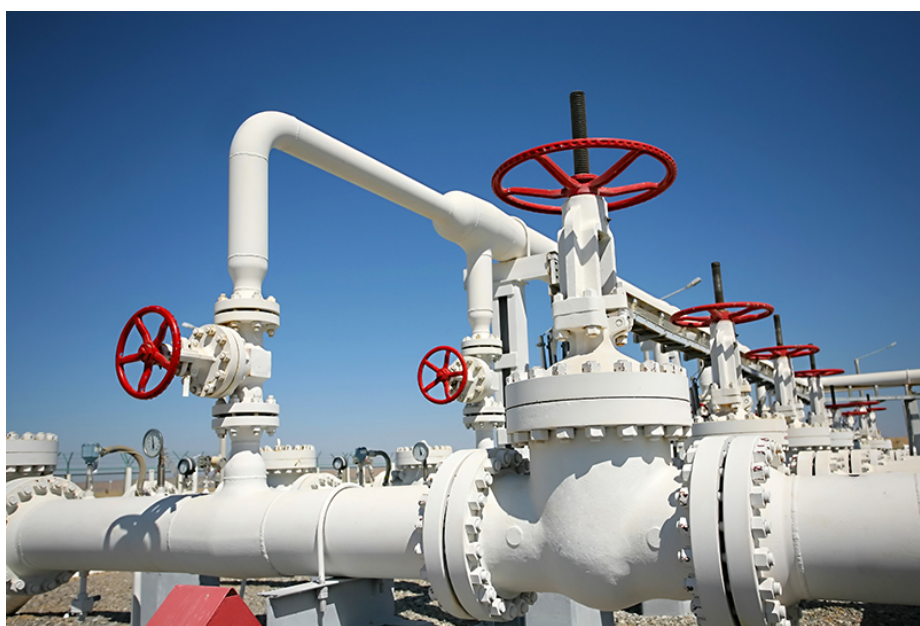
Εικόνα 26: Βαλβίδες διαχείρισης ροής σε σύστημα μεταφοράς φυσικού αερίου
