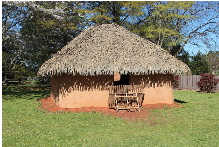
Εικόνα 1. Τοιχοποιία κατοικίας κατασκευασμένης με την τεχνική πεπλεγμένων ξύλινων βεργών [πηγή: Wikimedia Commons , Creative Commons CC0 1.0 Universal Public Domain Dedication ]
