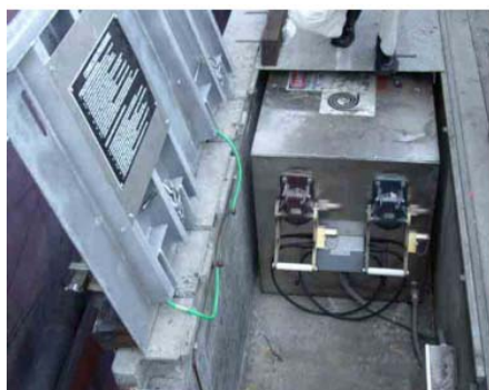
Εικ. 37. Υποδοχή καλωδίων [Πηγή: Cavotec]. Εικ. 38. Υποδοχή καλωδίων - Τομή πλάγιας όψης [Πηγή: Cavotec].
