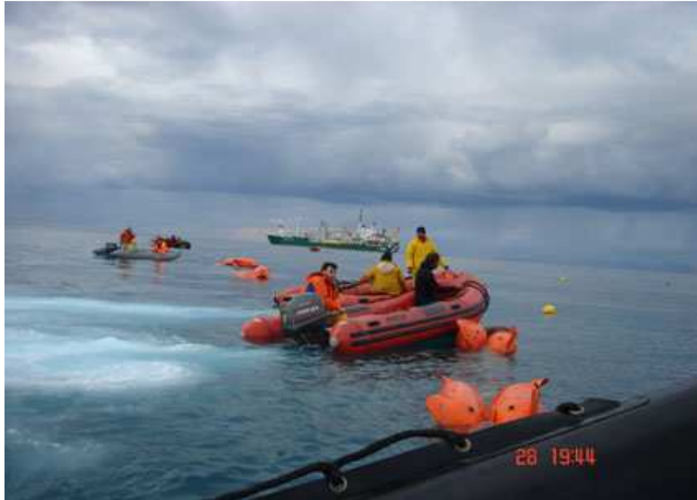
Εικόνα 3.6: Τοποθέτηση καλωδίου πάνω σε πλωτήρες κατά τη διαδικασία της πόντισης
