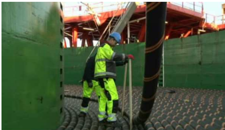
Εικόνα 4.3 :Τοποθέτηση καλωδίου από εξειδικευμένο προσωπικό
