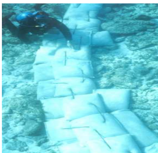
Εικόνα 2.15:Σύστημα συγκρατήσεως καλωδίων με σάκους από οπλισμένο σκυρόδεμα
