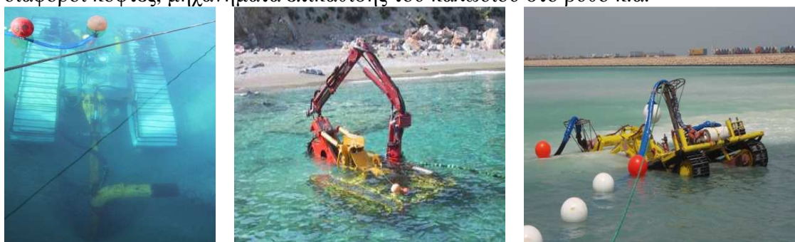
Εικόνα 4.12: σκαπτικά μηχανήματα διάνοιξης χάνδακος
