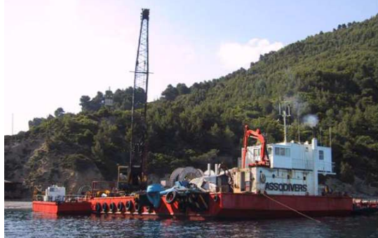
Εικόνα 4.33: Διάφορες λήψεις πλωτής φορηγίδα «Assodiver VII» σε επιχείρηση πόντισης υποβρύχιου καλωδίου
