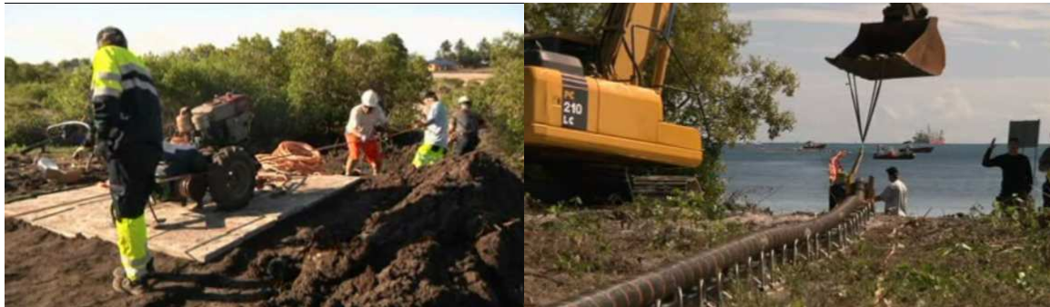
Εικόνα 3.7: Αριστερά Εργάτης έλξης καλωδίου στο σημείο πάκτωσης. Δεξιά Ραουλόδρομος όδευσης καλωδίου στο σημείο προσαιγιάλωσης.
