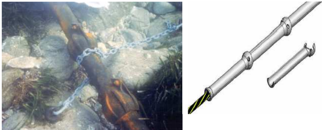
Εικόνα 2.16 : Διαιρούμενα κελύφη προστασίας Υ/Β καλωδίων. Στην Αριστερή εικόνα διακρίνεται σύστημα συγκρατήσεως με αλυσίδα του καλωδίου.
