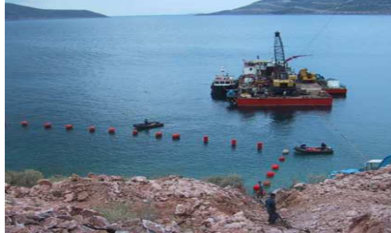
Εικόνα 4.33: Διάφορες λήψεις πλωτής φορηγίδα «Assodiver VII» σε επιχείρηση πόντισης υποβρύχιου καλωδίου
