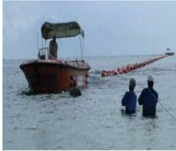
Εικόνα 3.9: Αριστερά Διαδικασία όδευσης καλωδίου στο δεύτερο σημείο προσαιγιάλωσης Δεξιά Μεταφορά καλωδίου με πλωτήρες προς την ακτή
