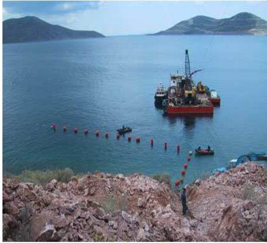
Εικόνα 3.9: Αριστερά Διαδικασία όδευσης καλωδίου στο δεύτερο σημείο προσαιγιάλωσης Δεξιά Μεταφορά καλωδίου με πλωτήρες προς την ακτή
