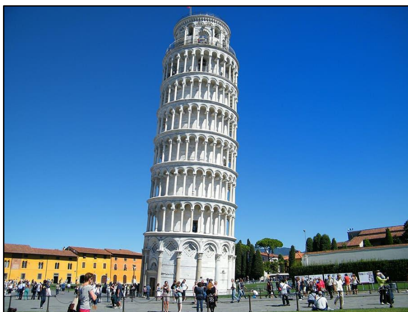
Εικόνα 2.1 : Ο πύργος της Πίζας αποτελεί ένα από τα πιο διαδεδομένα παραδείγματα αστοχίας που οφείλονται σε ελλιπή γνώση γεωτεχνικών παραμέτρων της περιοχής κατασκευής
