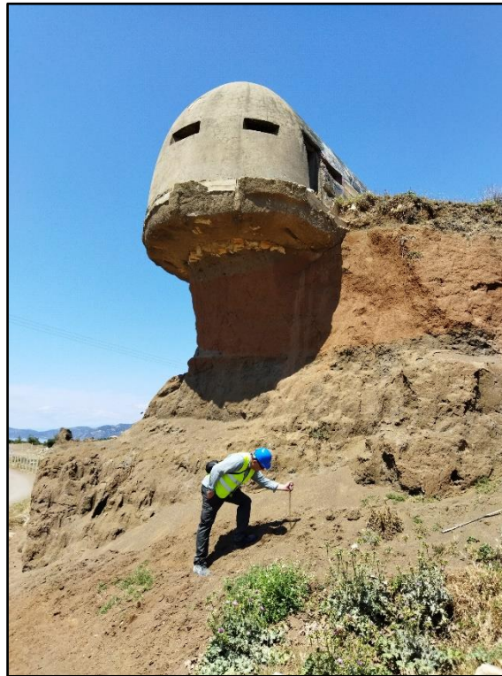
Εικόνα 2.9 :Κατακόρυφο πρηνές αργιλικού εδάφους, Ισθμός Κορίνθου
