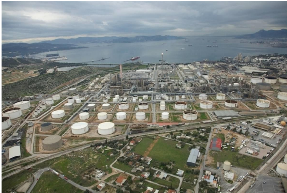
Εικόνα 34: Εγκαταστάσεις ΕΛΠΕ Ασπροπύργου (Πηγή: https://www.reporter.gr/Periballon/411542-Τροποποιούνται-oi-periballontikoi-oroi-gia-to-diylithrio-twn-ELPE )
