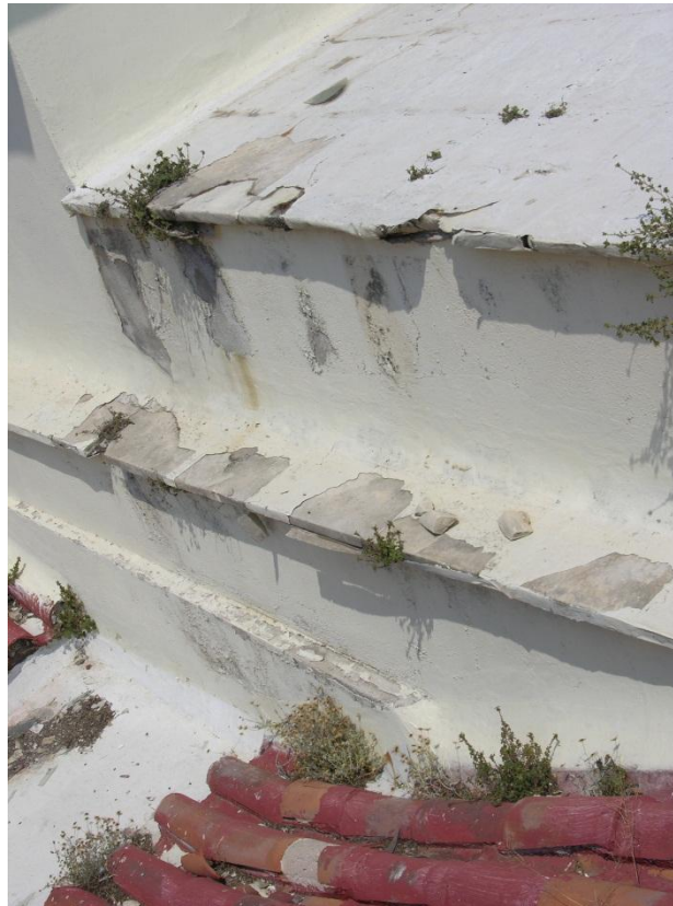
Εικόνα 4.21- Τα φθαρμένα επιχρίσματα στις βάσεις των τρούλων, η διαβρωμένη μόνωση και η βλάστηση η οποία έχει αναπτυχθεί σε πολλά σημεία.
