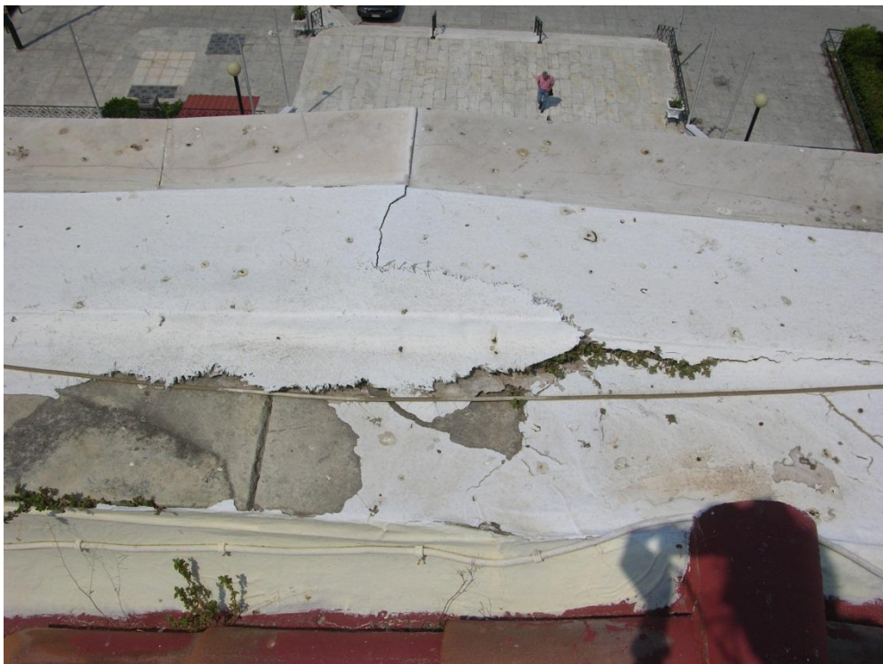
Εικόνα 4.19- Οι διανοιξίξεις και οι αποσαθρώσεις των αρμών των μαλτεζοπλακών
