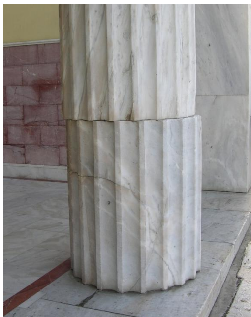
Εικόνα 4.13- Μετατόπιση σφονδύλου του δυτικού κίονα του βόρειου Προπύλου εξαιτίας βομβαρδισμού κατά τη διάρκεια του Β' Παγκοσμίου πολέμου
