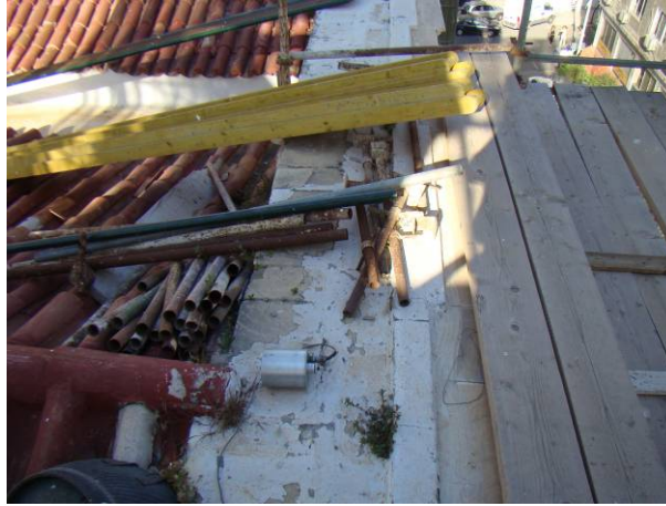
Εικόνα 5.11- Τοποθέτηση οργάνων στο δάπεδο ισογείου Κανάλι 3.
