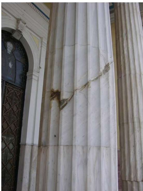
Εικόνα 4.14- (α) Ρηγμάτωση σε σφόνδυλο του βορείου Προπύλου, (β) διανοιγμένοι αρμοί στα μάρμαρα των παραθύρων του τρούλου
