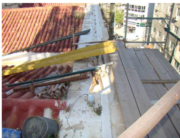
Εικόνα 5.9- Τοποθέτηση οργάνων στην οροφή θολοδομίας Κανάλι 3.
