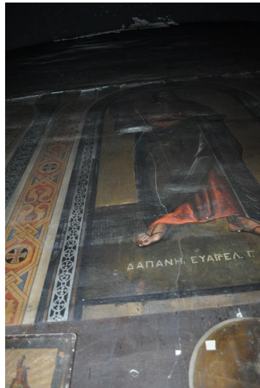
Εικόνα 4.3- Ρωγμές στη δυτική τοιχοποιία (κεντρική είσοδος)
