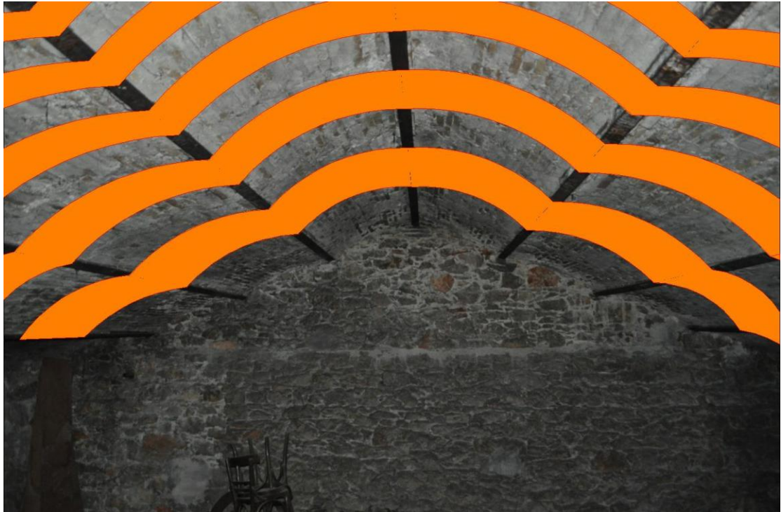
Εικόνα 7.1- Θέση ΙΝΠΑ 1Δ στην οροφή του δωματός άνωθεν του γυναικωνίτη
