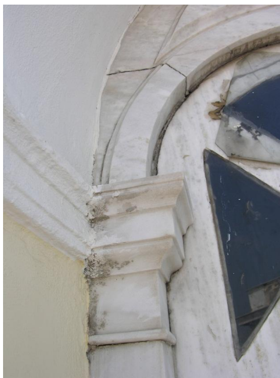
Εικόνα 4.14- (α) Ρηγμάτωση σε σφόνδυλο του βορείου Προπύλου, (β) διανοιγμένοι αρμοί στα μάρμαρα των παραθύρων του τρούλου
