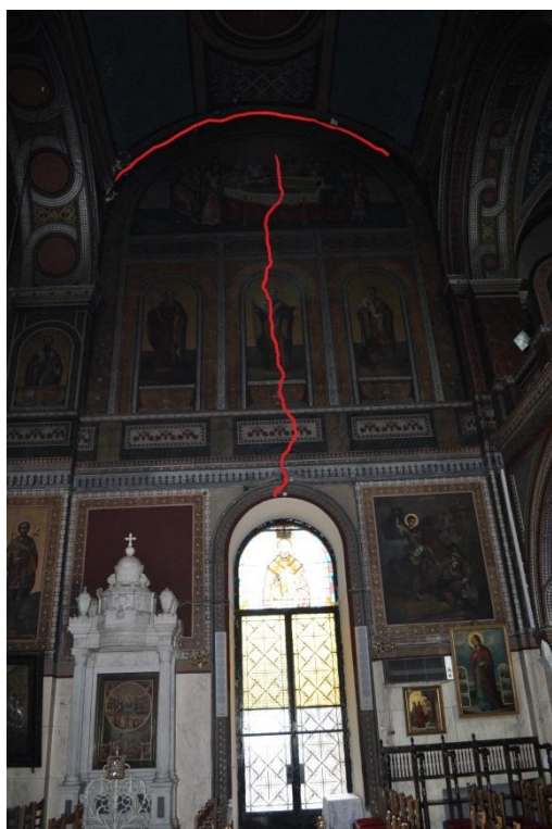
Εικόνα 4.1- Διαμετρής ρωγμή και αποκόλληση του τυμπάνου στη νότια τοιχοποιία (δεξιά είσοδος)
