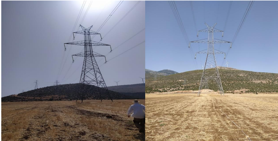
Εικόνα 6.22: Μέτρηση ηλεκτρικού πεδίου κατά μήκος του άξονα της γραμμής μεταφοράς.
