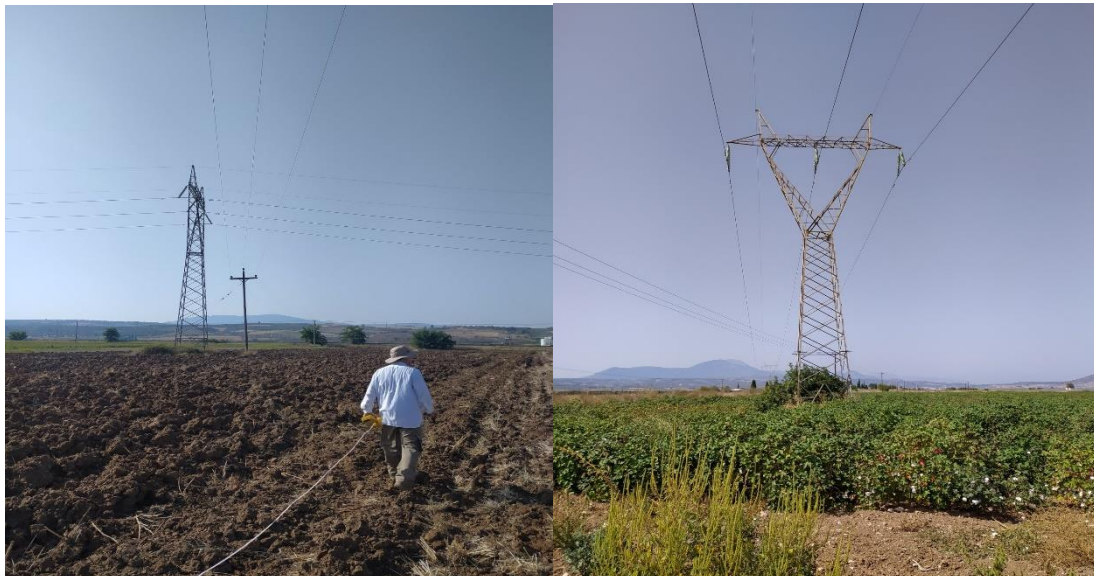
Εικόνα 6.16: Μέτρηση ηλεκτρικού πεδίου και μαγνητικού πεδίου σε άξονα εγκάρσιο προς τη γραμμή.
