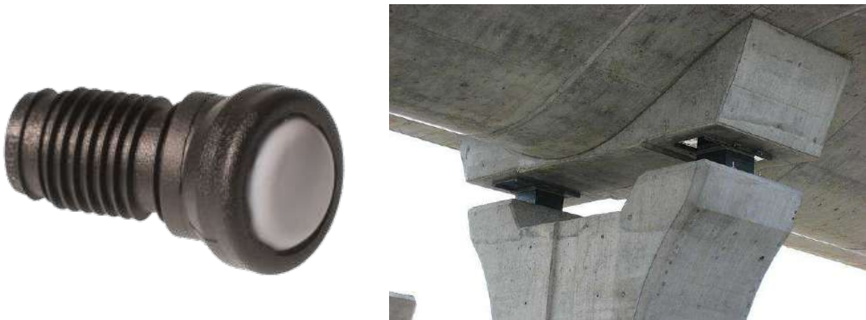
Εικόνα 8: Οι εφαρμογές του Teflon για την ολίσθηση μεγάλου εύρους αντικειμένων: α) Εξάρτημα ολίσθησης επίπλων και β) Bearding pads για ελεύθερη μετακίνηση άνω μέρους γέφυρας. Πηγές: https://www.plasticmetall.com/ggug2000-heavy-duty-nylon-tilt-glide-with-ptfe-surface.html και https://www.saturnprefab.co.in/products/bridge-bearing/
