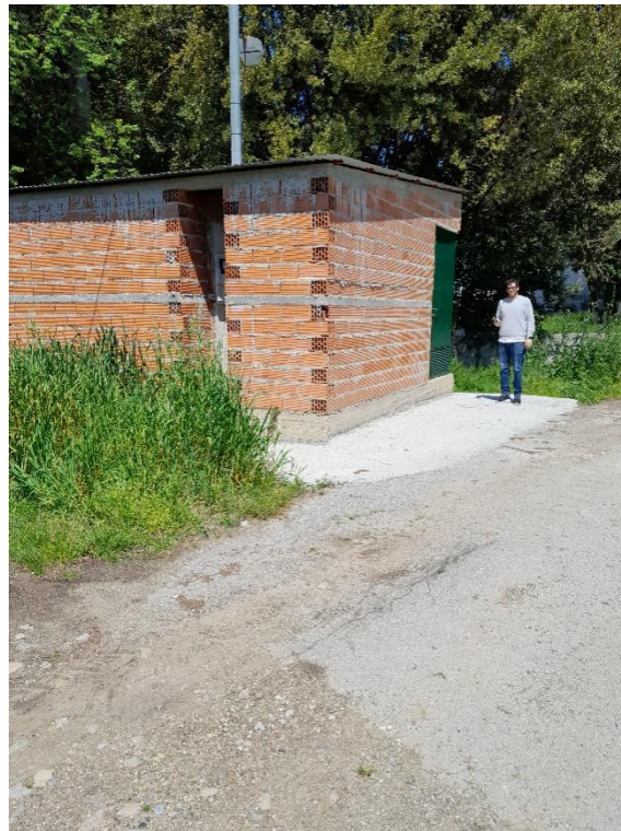
Εικόνα 16: Αναμνηστική εικόνα στην τελευταία θέση της αυτοψίας στο αντλιοστάσιο Κηρίνου
