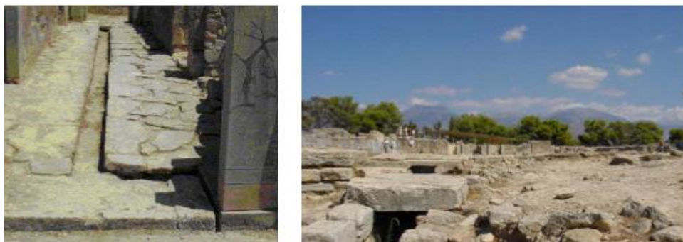
Εικόνα 3: Τμήματα του συστήματος αποχέτευσης στο ανάκτορο της Φαιστού, τμήμα εντός του ανακτόρου (αριστερά) και κεντρικός αποχετευτικός αγωγός (δεξιά) (Πηγή: Αγγελάκης και Δ.Κουτσογιάννης??? ετός)
