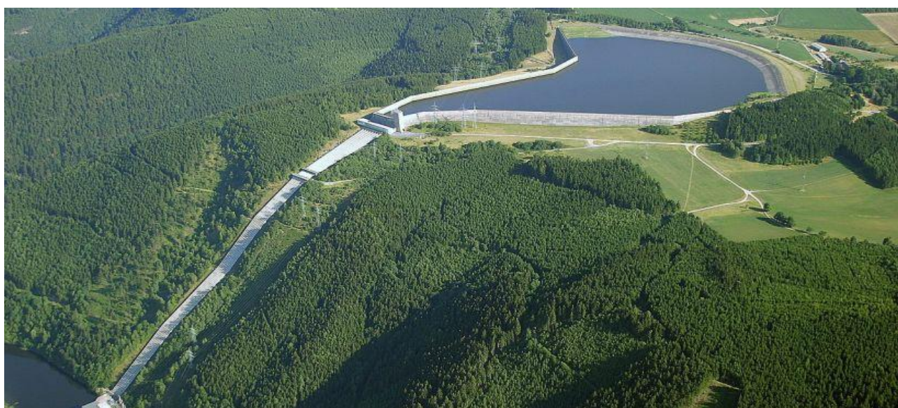
Εικόνα 1 Έργο αντλησιοταμίευσης στην Αμφιλοχία συνολικής εγκατεστημένης ισχύς 680 MW (παραγωγή) και 730 MW (άντληση) (Μαστοράκης Μιχάλης, 2022)
