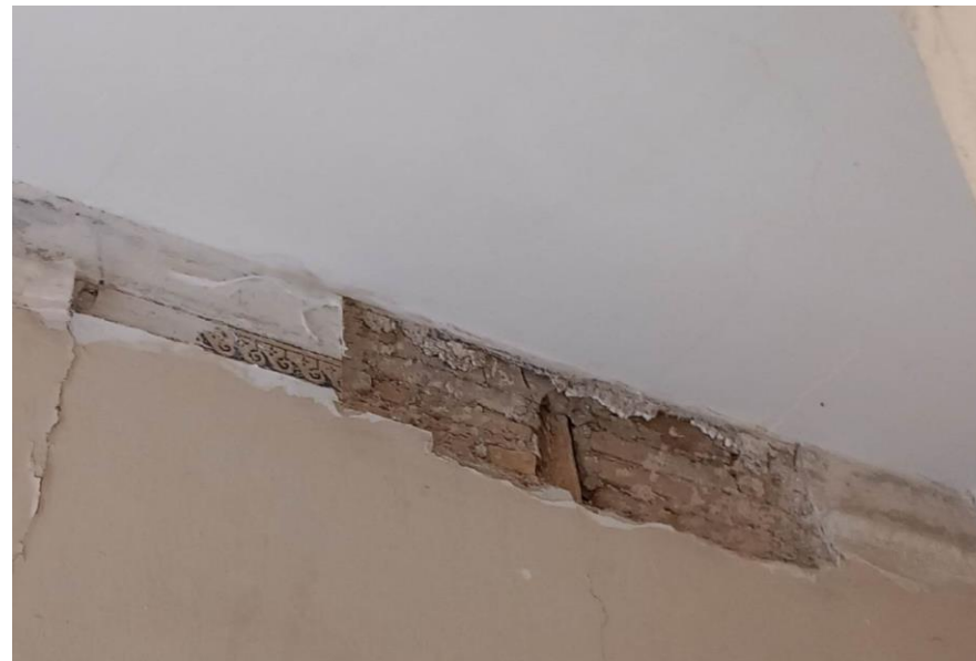
Εικόνα 2.9: Τμηματική αποξήλωση επιχρίματος σε εσωτερικό τοίχο του ισόγειου και αποκάλυψη της οπτοπλιθοδομής.
