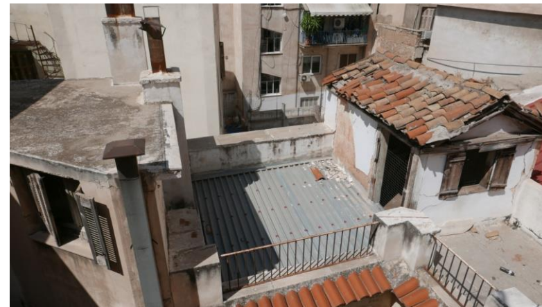
Εικόνα 2.19: Μικρή στέγη κτιρίου.
