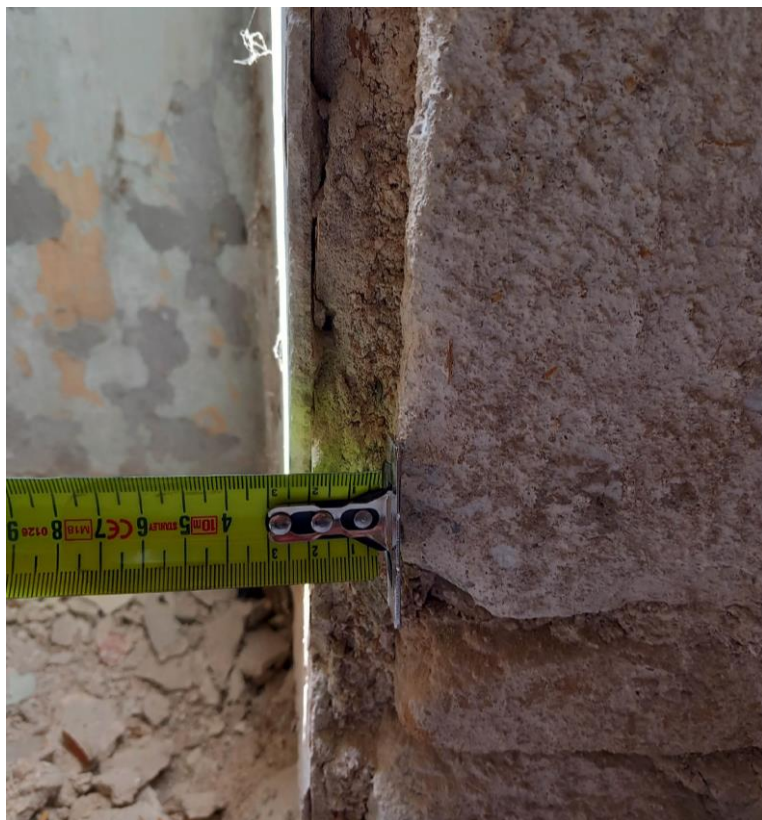
Εικόνα 2.3: Εσωτερικός και εξωτερικός σοβάς τοιχοποιίας πάχους 70cm.
