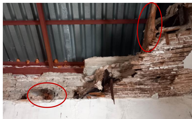
Εικόνα 2.21: Απεικόνιση ξύλινων δοκών και δοκοθηκών στη μικρή στέγη.
