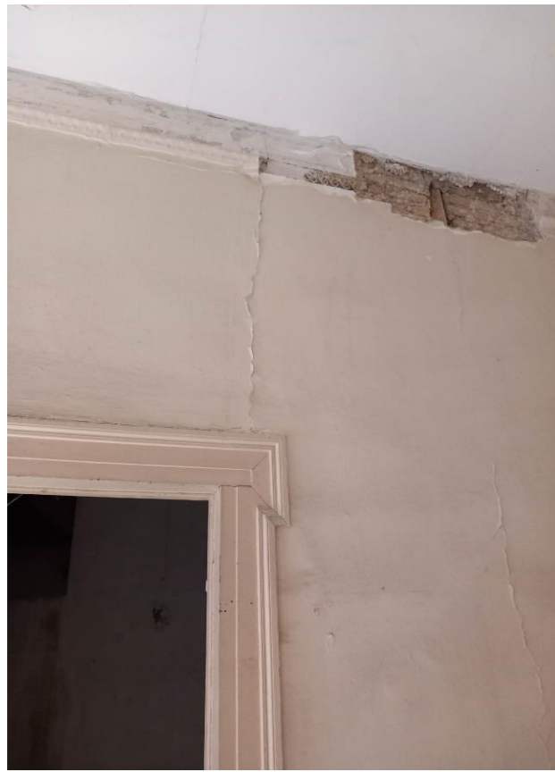
Εικόνα 4.13: Περιοχή ελέγχου σε ακμή εσωτερικής πόρτας στο ισόγειο.
