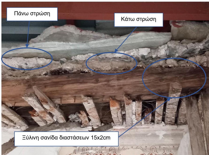
Εικόνα 2.22: Απεικόνιση του τρόπου κατασκευής της μικρής στέγης.
