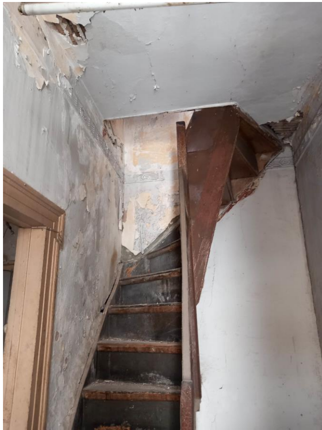
Εικόνα 4.12.: Περιοχή ελέγχου στη δεξιά γωνία του τοίχου στο κλιμακοστάσιο.
