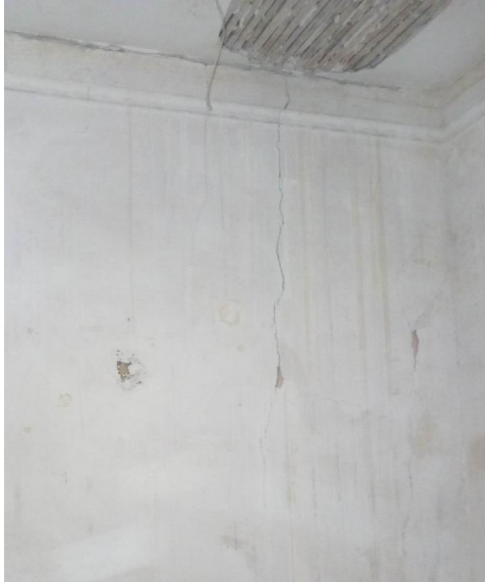
Εικόνα 4.11: Περιοχή ελέγχου στο μέσο ενός τοίχου του ισογείου.
