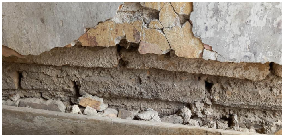
Εικόνα 2.8: Οπτοπλιθοδομή στο δώμα του κτιρίου.
