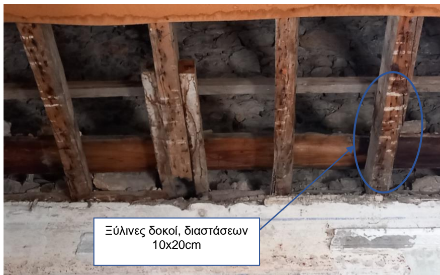
Εικόνα 2.23: Απεικόνιση των υπαρχόντων ξύλινων δοκών στη μεγάλη στέγη.
