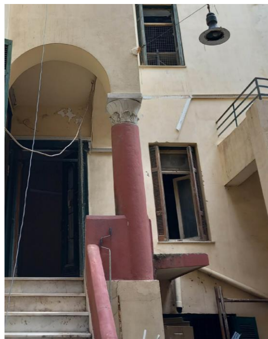
Εικόνα 2.26: Μαρμάρινο υποστύλωμα στην κεντρική είσοδο του κτιρίου.
