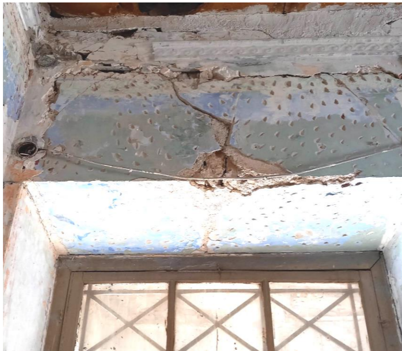
Εικόνα 4.15: Περιοχή ελέγχου σε υπέρθυρο στον όροφο.
