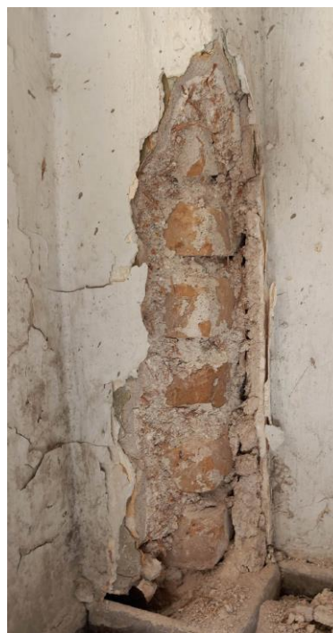
Εικόνες 2.5,2.6: Οπτοπλινθοδομή προεξοχής ορόφου και σκαρίφημα δόμησης οπτοπλινθοδομής.
