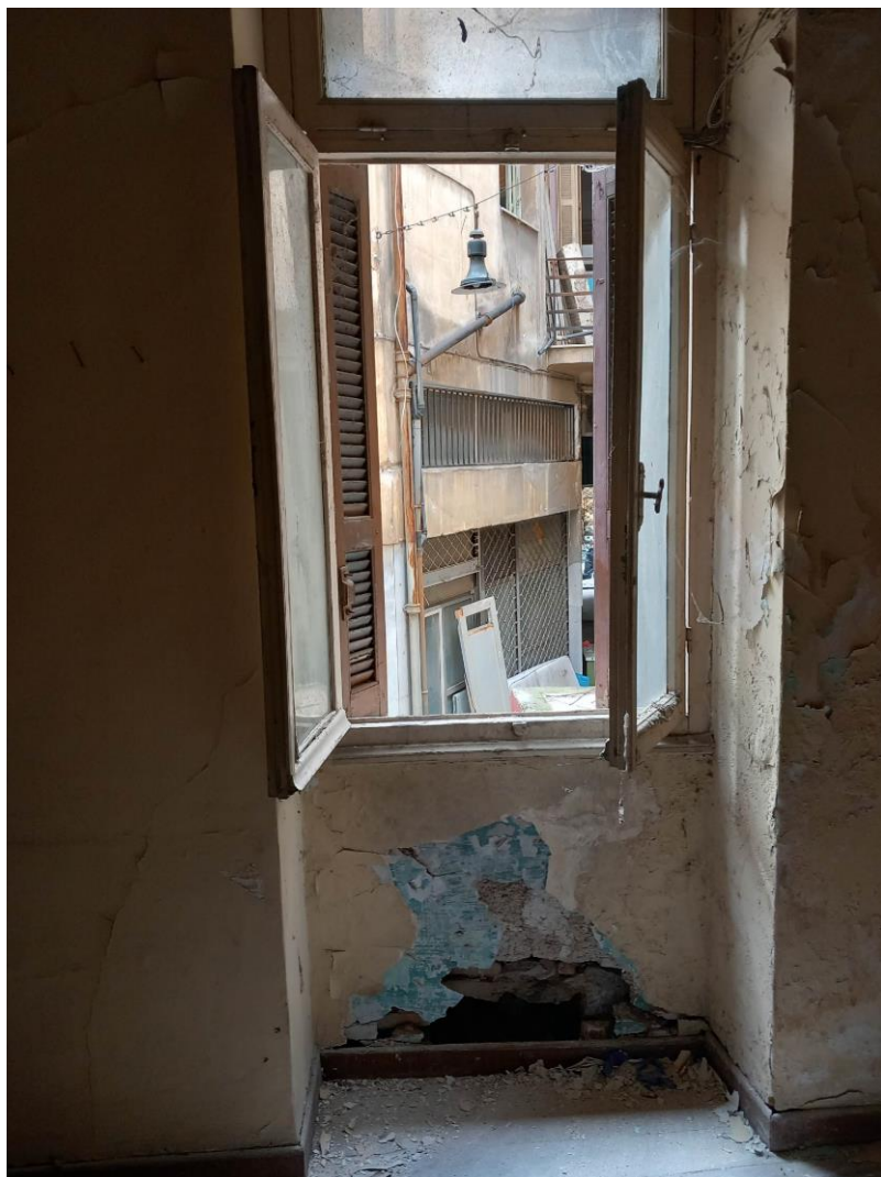
Εικόνα 1.10: Ξύλινο δίφυλλο παράθυρο με τζάμια στο ισόγειο του κτιρίου.
