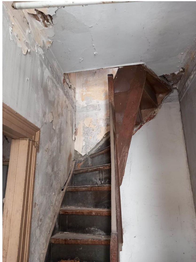
Εικόνα 1.17: Εσωτερική ξύλινη σκάλα που οδηγεί στο δώμα.
