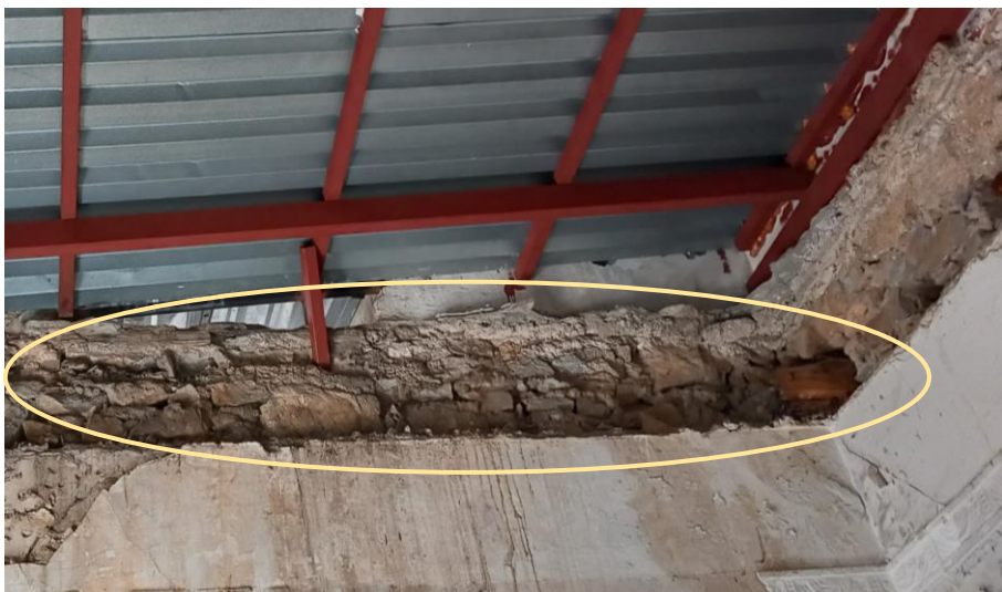
Εικόνα 2.25: Υπερυψωμένη τοιχοποιία στη μικρή στέγη.
