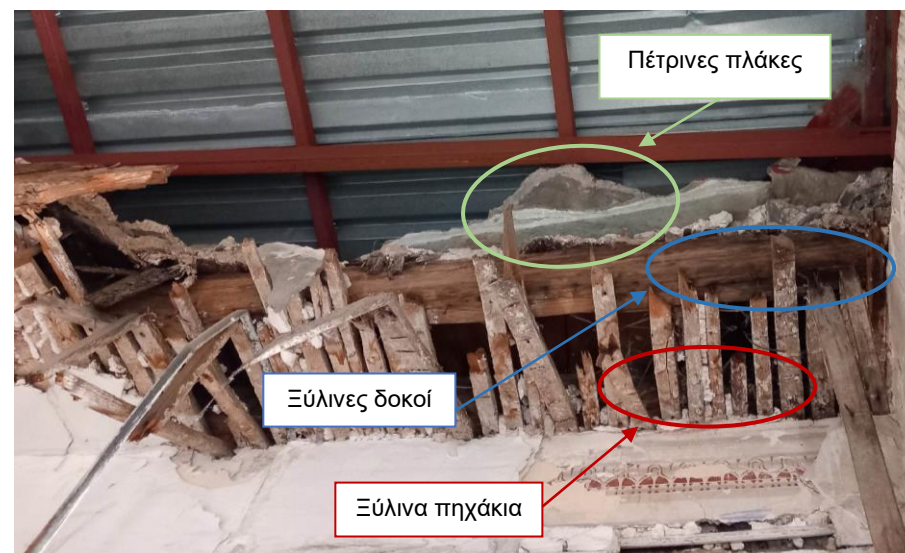
Εικόνα 2.20: Απεικόνιση του τρόπου κατασκευής της μικρής στέγης.
