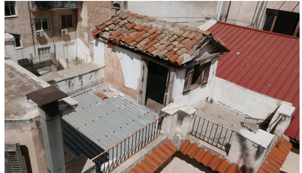
Εικόνα 1.19: Δώμα στην αριστερή πλευρά του κτιρίου.
