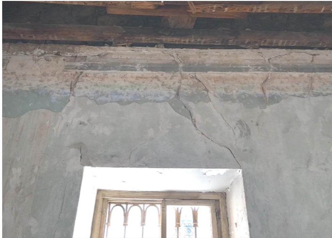
Εικόνα 4.9: Περιοχή ελέγχου πάνω από το παράθυρο του ορόφου στην εσωτερική όψη του κτιρίου.
