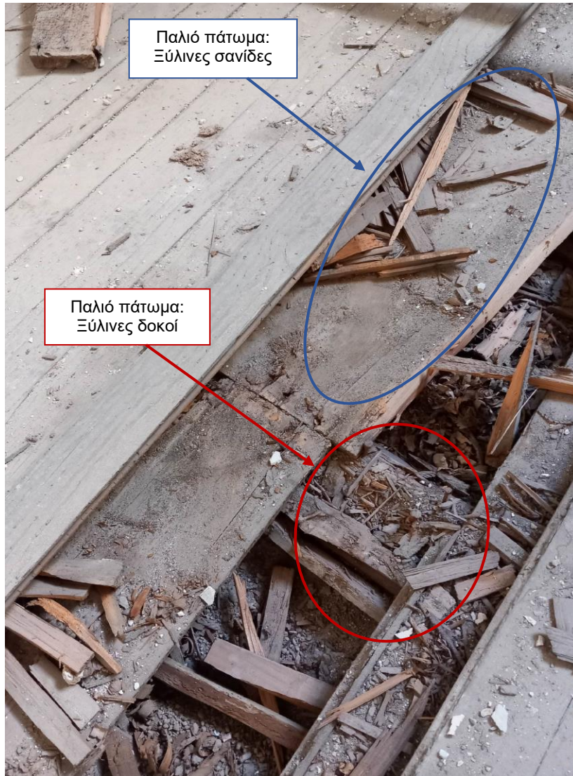
Εικόνα 2.14: Ξύλινες σανίδες και δοκοί του πατώματος στον όροφο.
