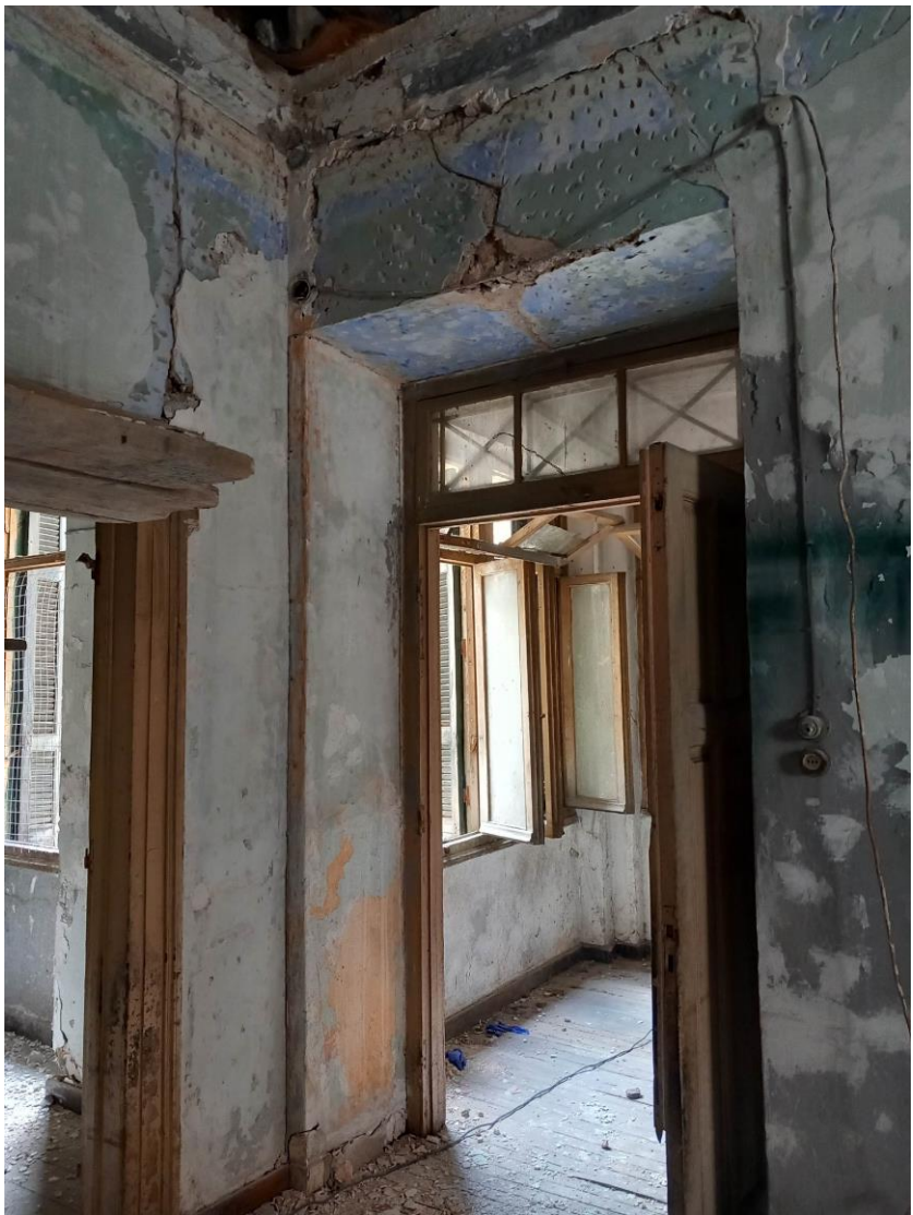
Εικόνα 1.16: Εσωτερική ξύλινη πόρτα με φεγγίτη και σιδεριά στον όροφο του κτιρίου.
