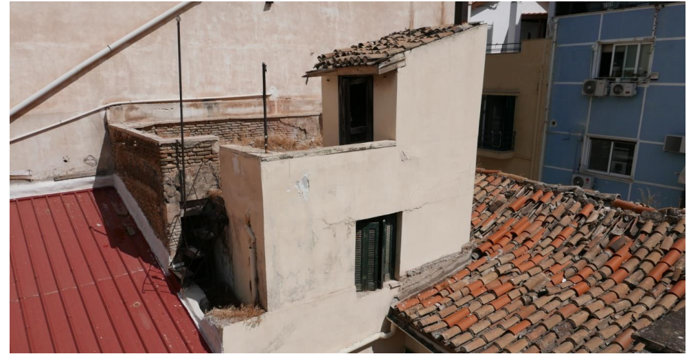
Εικόνα 1.18: Δώμα στην δεξιά πλευρά του κτιρίου.
