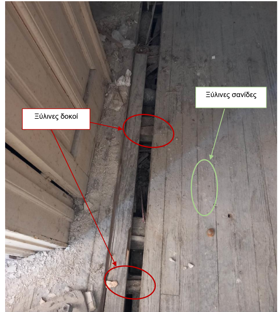
Εικόνα 2.13: Ξύλινες δοκοί και σανίδες του πατώματος στο ισόγειο.
