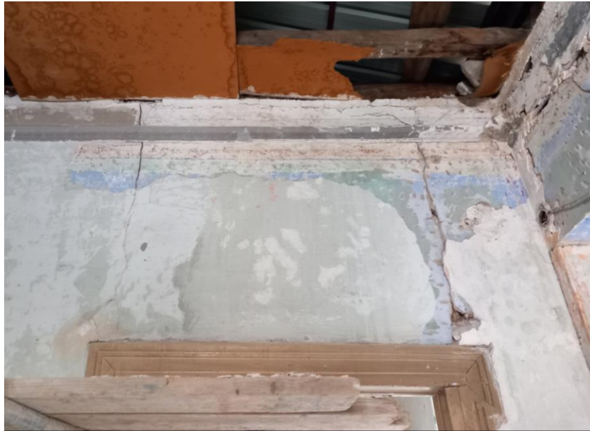
Εικόνα 4.16: Περιοχή ελέγχου σε υπέρθυρο στον όροφο.
