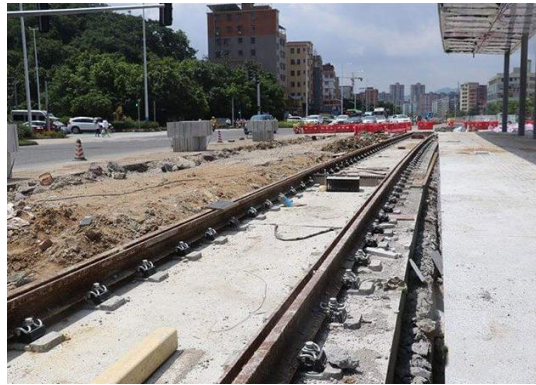
Figure 2.17: Παράδειγμα εφαρμογής μιας σύγχρονης σιδηρογραμμής τροchioδρόμου σε αντιστοιχία με το Figure 2.18 (από rail-fastener.com)
